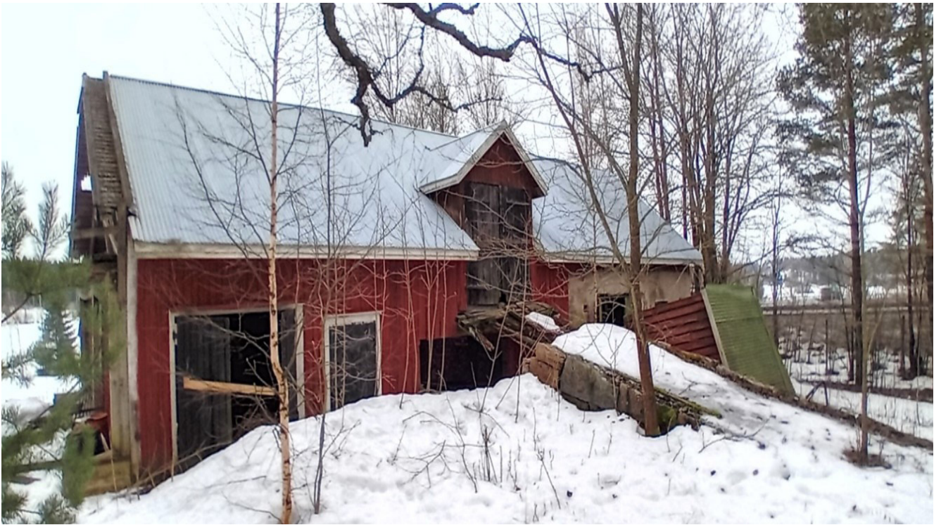
Kuva 13. Keupasin navetan pihanpuoleinen luoteisjulkisivu. Figur 13. Ladugårdens fasad mot gården och nordväst.
