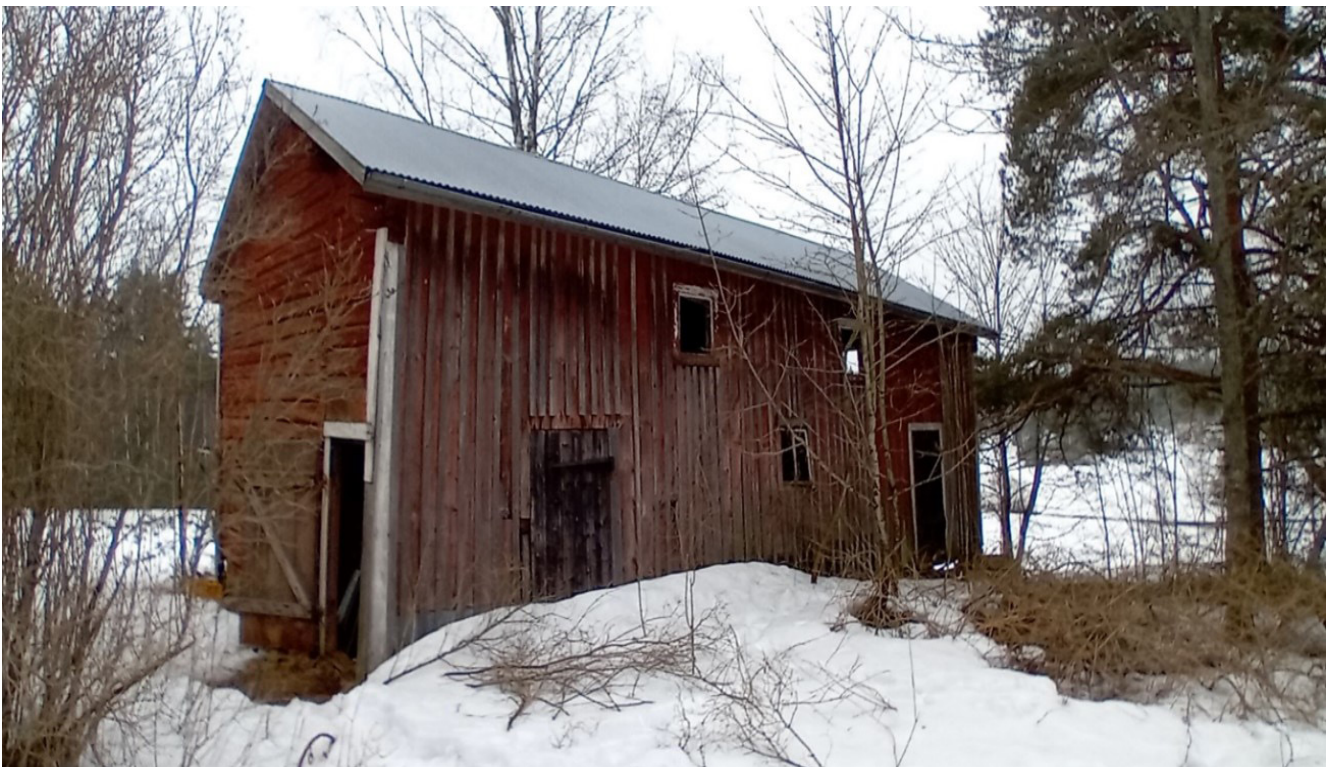
Kuva 14. Aitan luoteispääty ja lounaisjulkisivu. Figur 14. Bodens sydvästra gavel och fasad mot sydväst.
