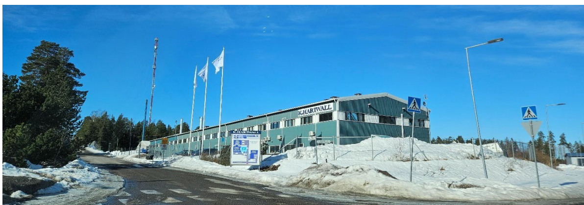
Figur 4.4. Arbetsplatsbyggnad vid Borgåleden.
