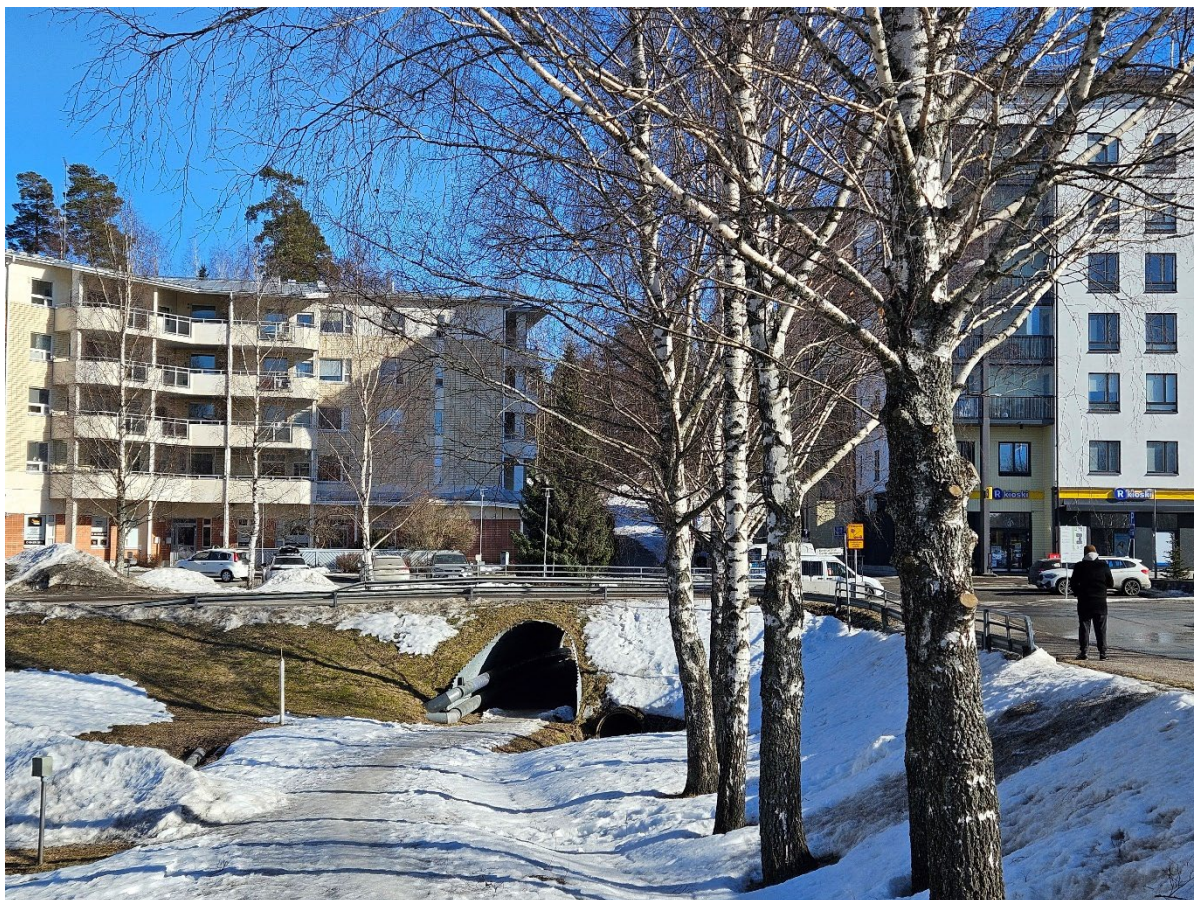
Figur 3.30. Gång- och cykelvägar på Centrumvägen och under Amiralsvägen.
