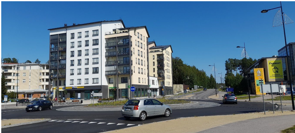
Kuva 4.1. Näkymä Söderkullan keskustasta Uusi Porvoontielle. Kuva © Henna Malinen.
