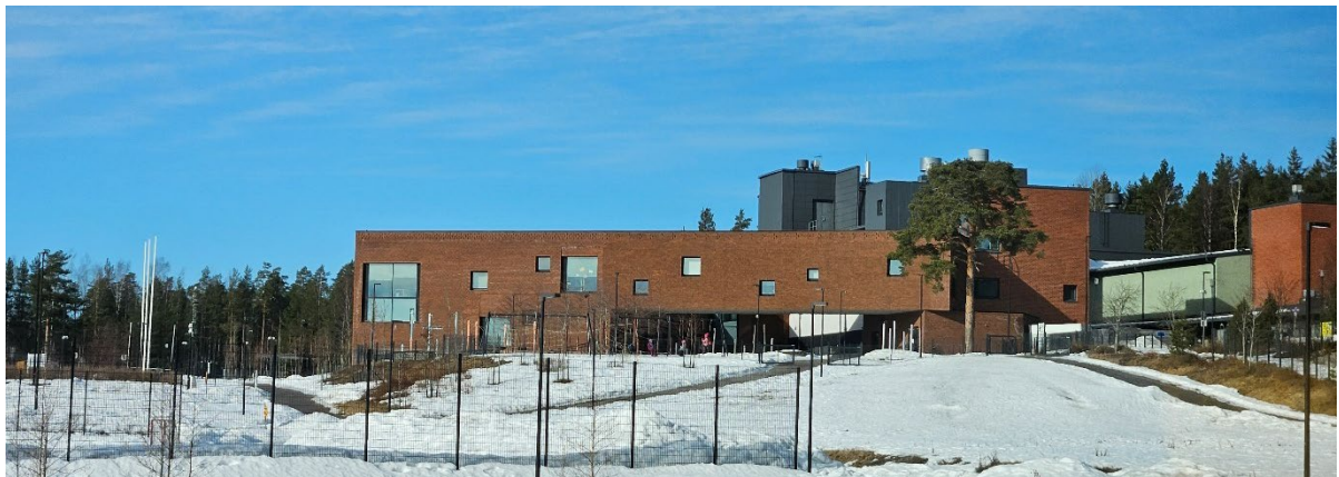
Kuva 3.21. Söderkullan keskustassa sijaitseva Sipoonlahden koulu.
