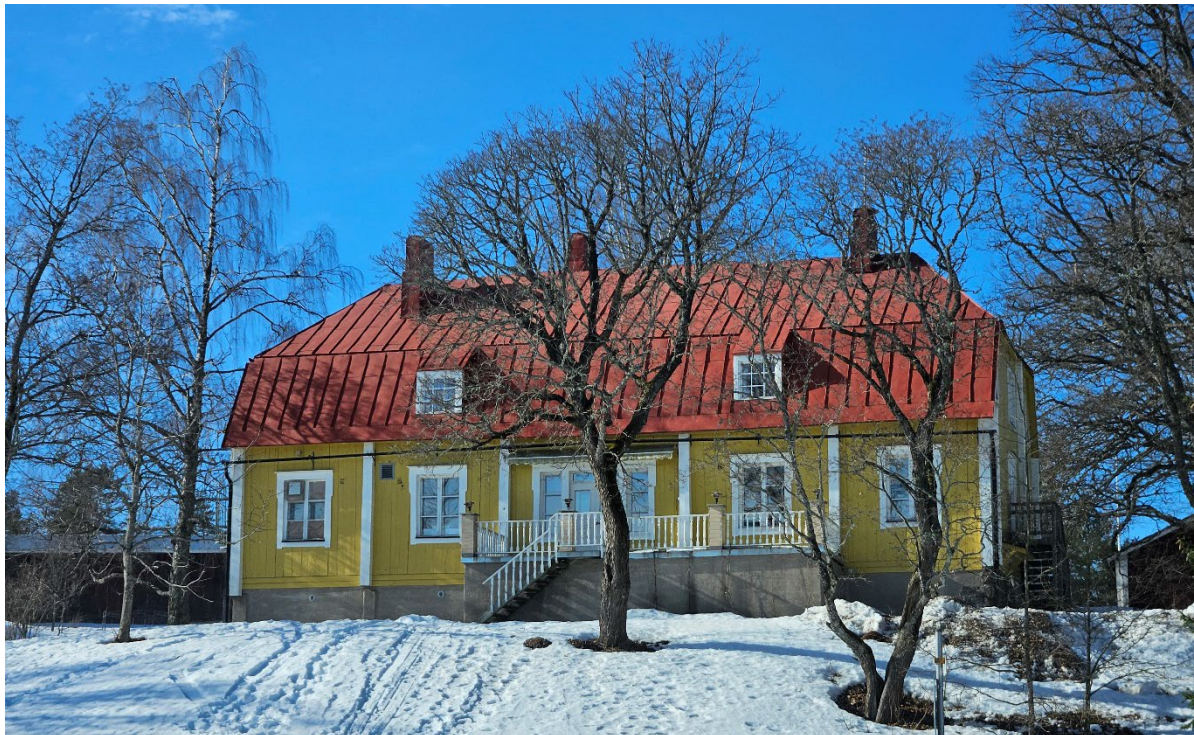
Kuva 3.11. Söderkullassa sijaitsee uudemman rakennuskannan ohella vanhempaa 1900-luvun alun rakennuskantaa. Kuvassa on Joensuun tilan päärakennus.
