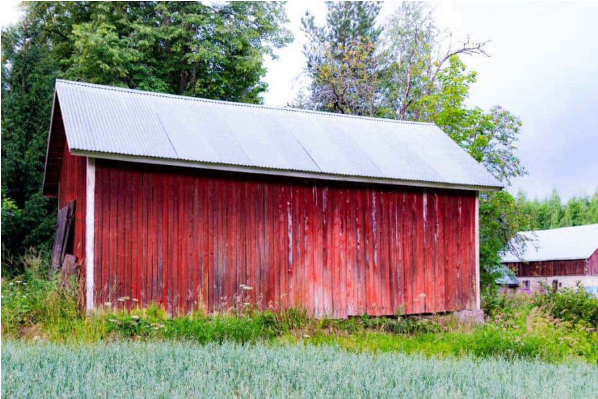
Kuva 11. Asuinrakennuksen pohjoispuolella sijaitseva ulkorakennus.
