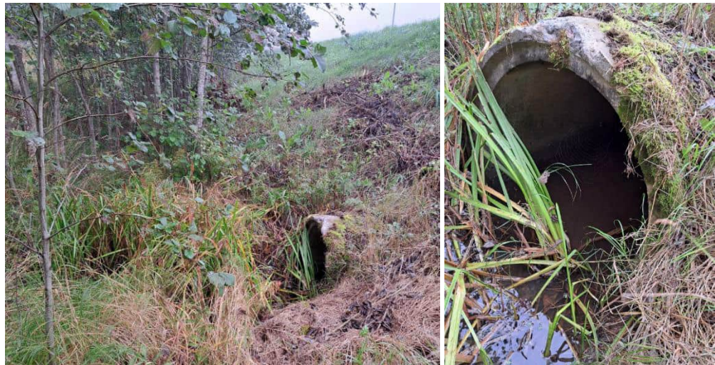
Kuva 10. Maantierumpu, jonka kautta alueelle kulkeutuu pintavesiä alueen eteläpuolelta. Kuva © Destia Oy 9/2024.
