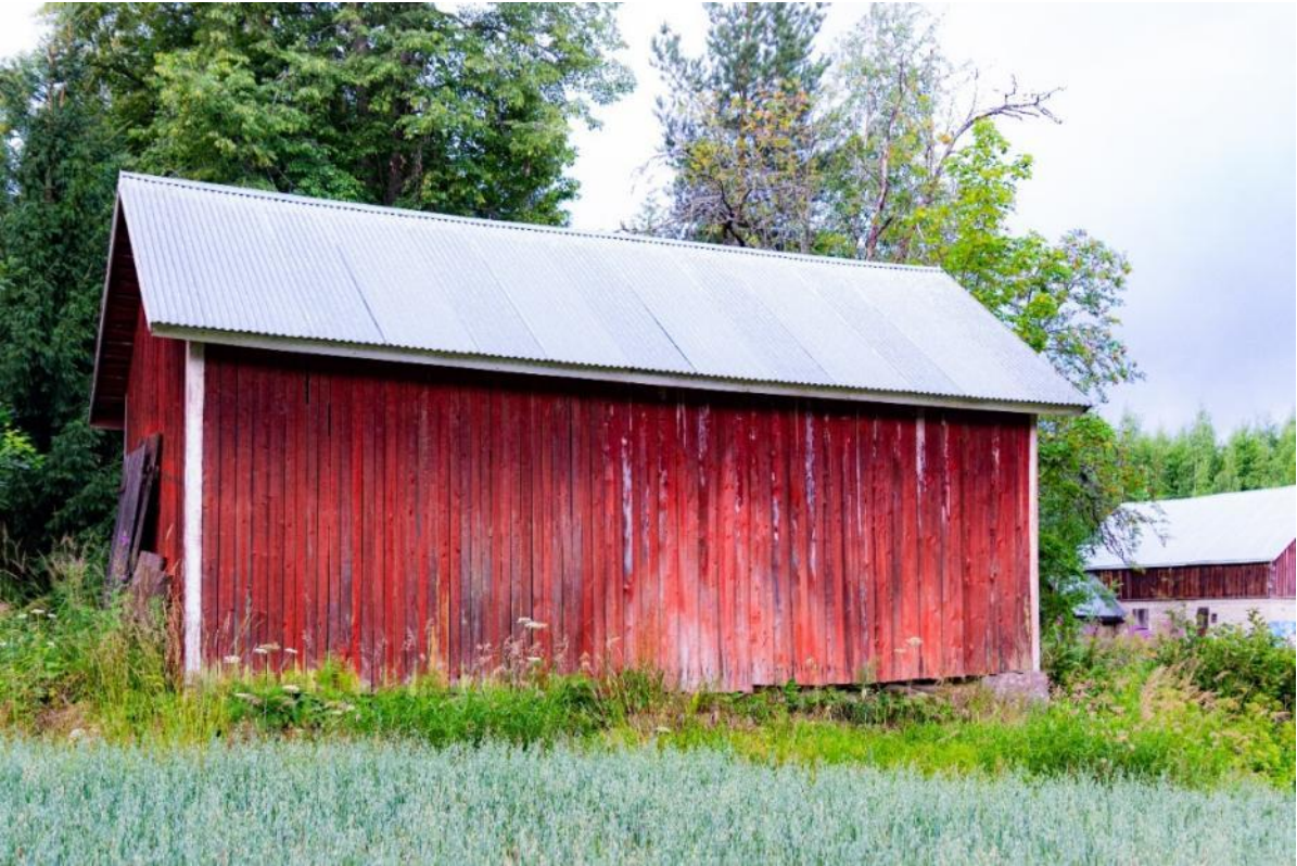
Kuva 11. Asuinrakennuksen pohjoispuolella sijaitseva ulkorakennus.
