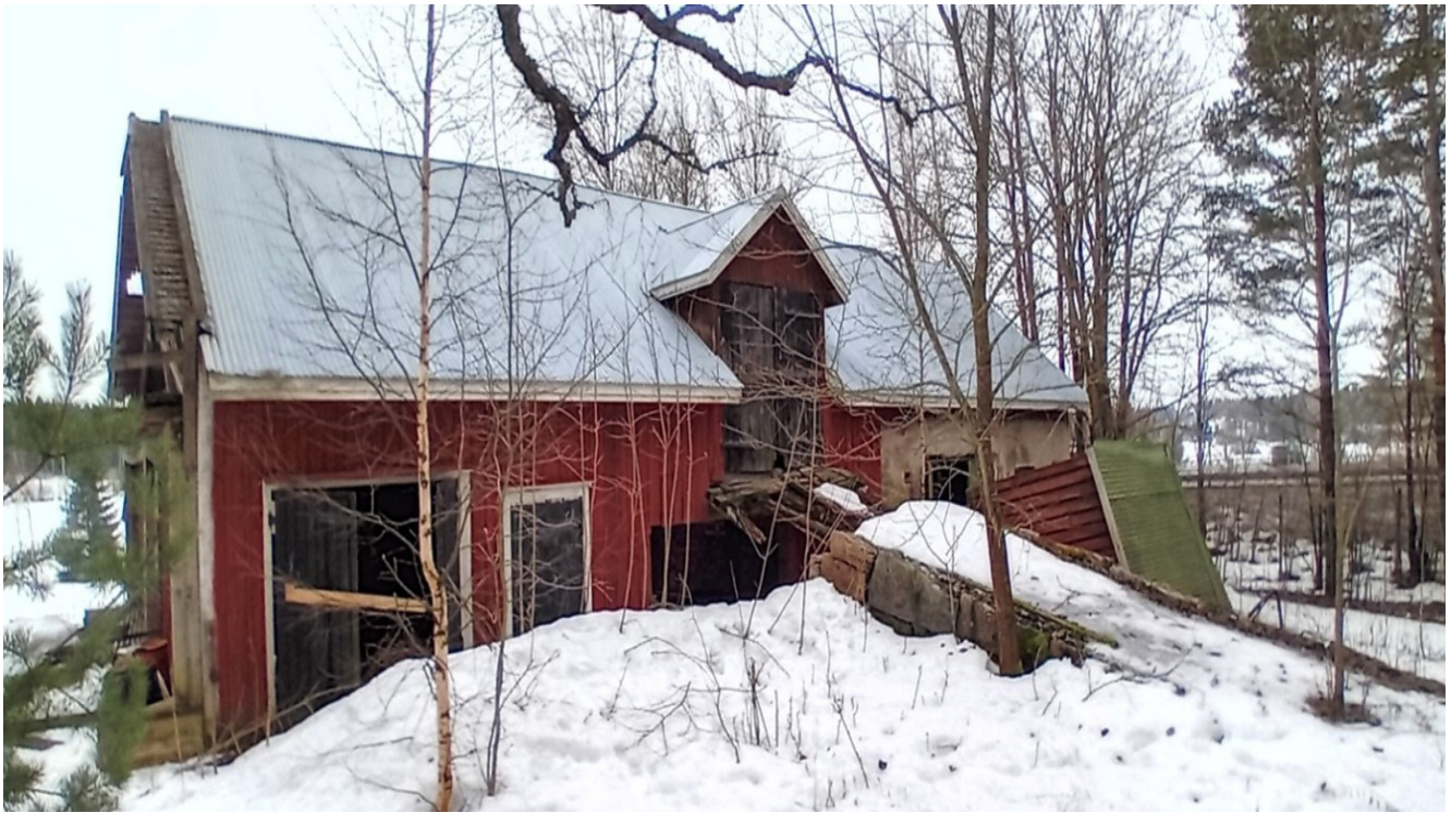
Kuva 10. Keupasin navetan pihanpuoleinen luoteisjulkisivu. Bild 10. Ladugårdens fasad mot gården och nordväst.
