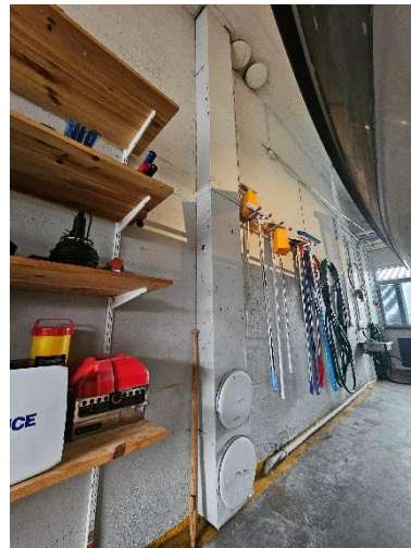
Kuva 104. Korjaamotilan oletettu lattia-rajapoisto.
