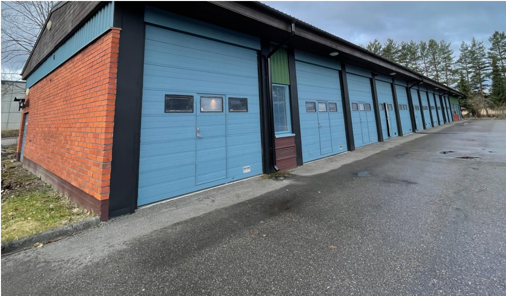
Kuva 5. Lämmin varasto. Asfalttipinnoitteen kallistukset ok. Asfalttipinnoite on hyväkuntoinen.
