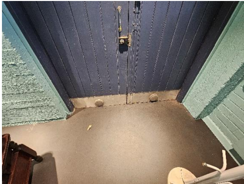
Kuva 97. Ovien korvausilmaventtiileitä.
