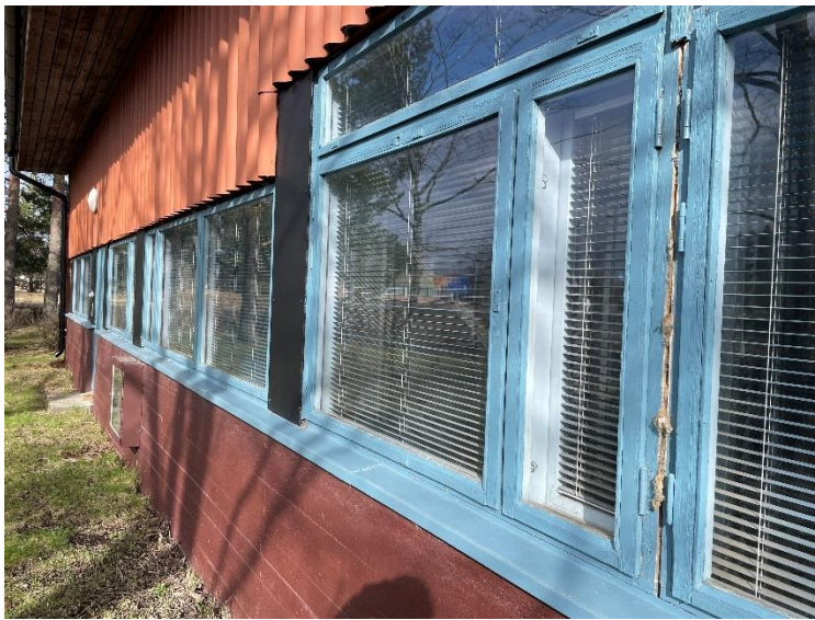
Kuva 34. Ikkunat ovat hiljattain maalattu. Yksittäinen listoitus puuttuu.
