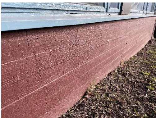
Kuva 6. Sokkelin halkeama.
