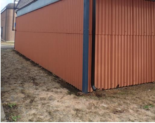
Kuva 8. Kylmän varaston matala sokkeli.
