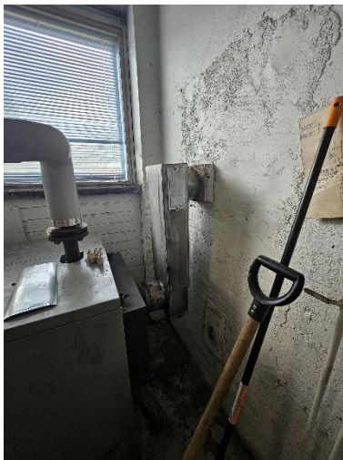
Kuva 99. Öljypolttimen pakokaasunpoisto.
