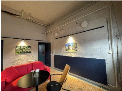
Kuva 49. Taukotilan pinnat hyväkuntoiset.
