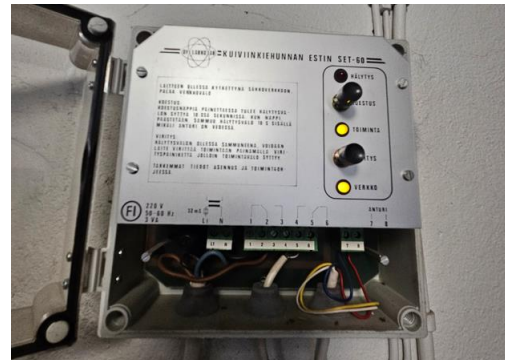
Kuva 64. Lämminvesivaraajan kuiviin kiehumman estin
