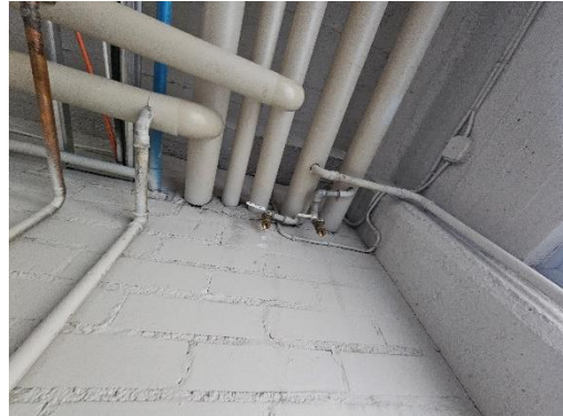
Kuva 81. Puutteellisia tulppauksia.
