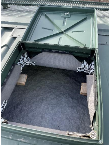
Kuva 46. Tarkastusluukku yläpohjatilaan
