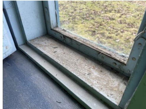
Kuva 38. Ulkopuite kulunut.
