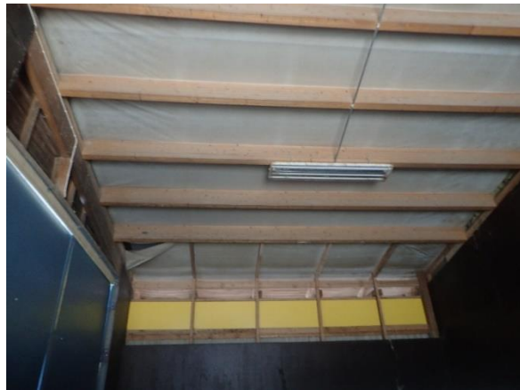
Kuva 48. Kylmän varaston aluskate repsottaa paikoin ja aluskatteessa havaittiin yksittäinen kosteusjälki.
