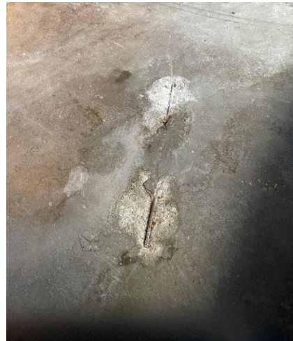
Kuva 14. Betonilaatan lohkeama.
