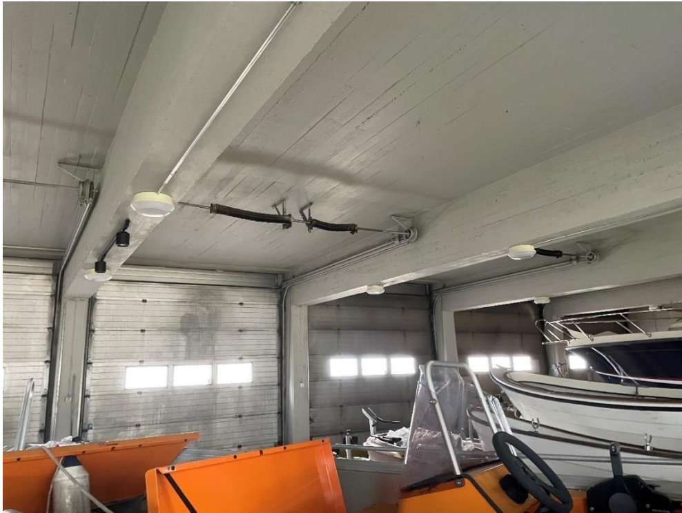
Kuva 19. Lämpimän varaston kantava betonirunko on hyväkuntoinen.
