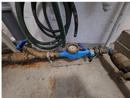
Kuva 74. Kiinteistön päävesimittari.
