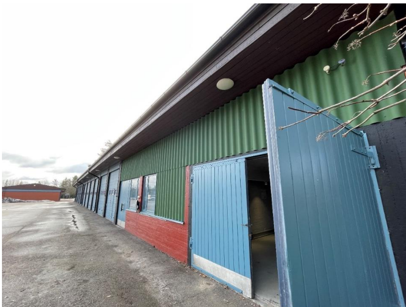
Kuva 24. Lämpimän varaston julkisivu sisäpihalle. Julkisivupinnat olivat hyväkuntoiset ja hiljattain pinnoitettu.
