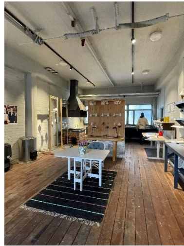
Kuva 50. Paikoin tiloissa on lautalattia, jonka pinnassa paikoin kulumaa.
