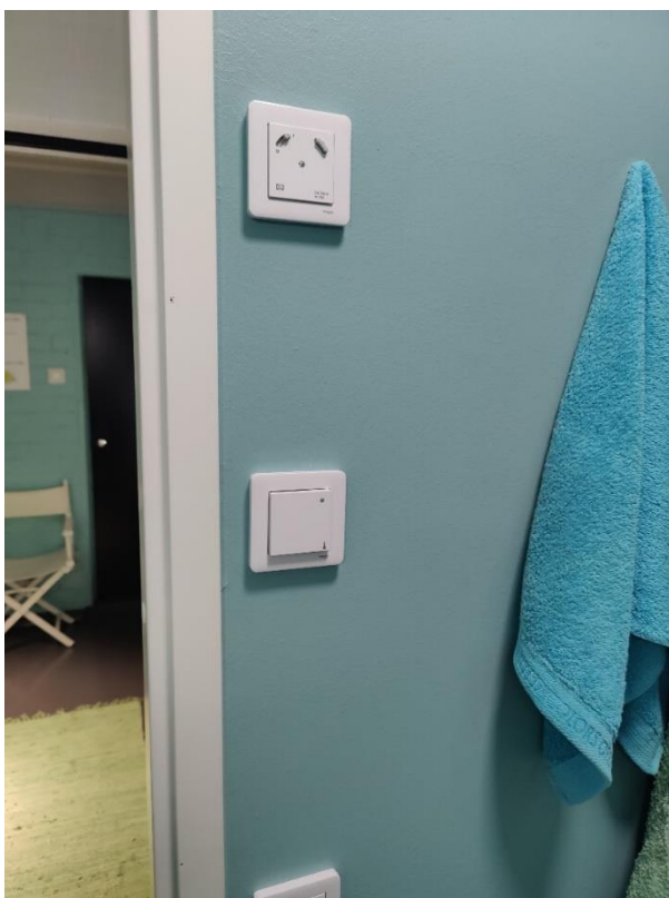
Kuva 123. Uusittuja sähkökalusteita WC-tilassa
