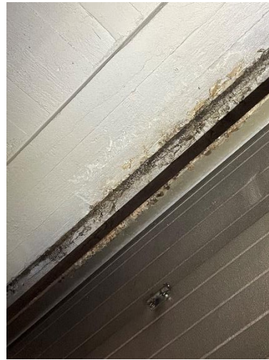
Kuva 42. Nosto-ovien yläosissa kosteusjälkiä.
