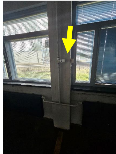
Kuva 73. Hallitilojen pattereiden termostaattiventtiilit on sijoitettu melko korkealle ikkunoiden väliin, jossa pattereista nouseva lämpö ja aurinko voivat vaikuttaa sen toimintaan.
