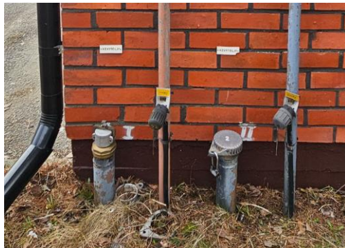
Kuva 63. Öljysäiliön täyttö
