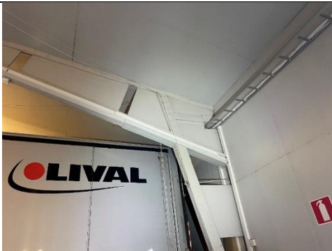
Kuva 22. Kylmän varaston puurunko on hyväkuntoinen.
