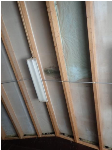
Kuva 48. Kylmän varaston aluskate repsottaa paikoin ja aluskatteessa havaittiin yksittäinen kosteusjälki.
