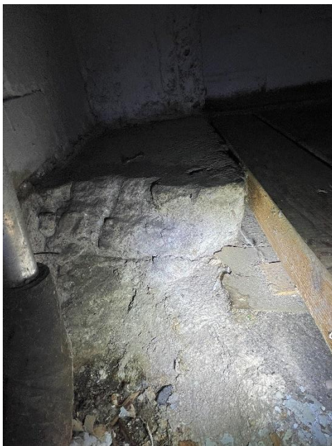
Kuva 15. Lattian puurakenne on erotettu betonirakenteesta.
