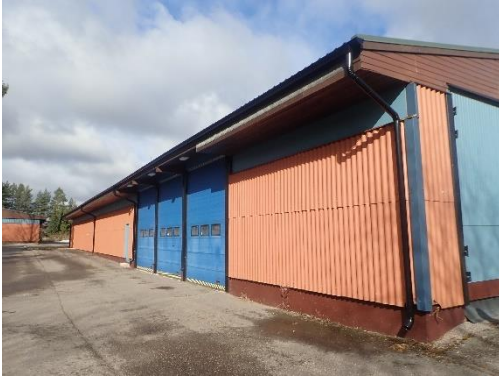
Kuva 25. Kylmän varaston julkisivut ovat pääosin kovalevyä.
