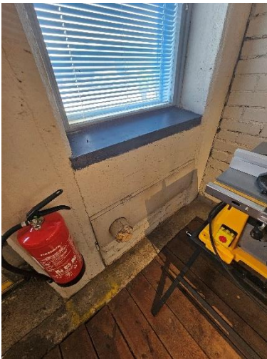
Kuva 103. Tukittu korvausilmaventtiili.
