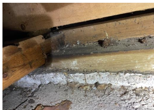
Kuva 11. Puurakenne tummunut.
