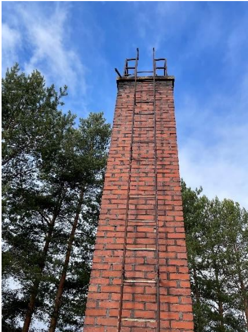
Kuva 29. Lämmityshormin muraussaumat ovat rapautuneet.
