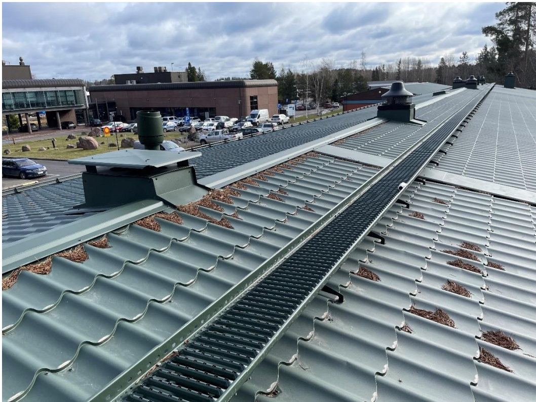
Kuva 45. Yleiskuva rakennuksen 1 vesikatosta. Vesikatteet on uusittu kesällä 2023
