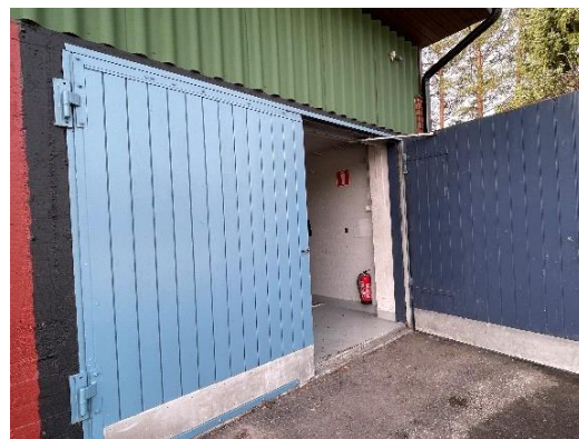
Kuva 40. Lämpimän varaston ulko-ovi.
