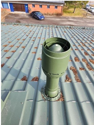
Kuva 105. Kattoremontin yhteydessä uusittu huippumuri.
