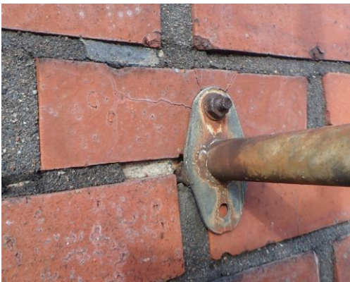
Kuva 29. Lämmityshormin muraussaumat ovat rapautuneet.
