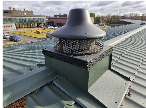
Kuva 106. Alkuperäinen poistoilmapuhallin.
