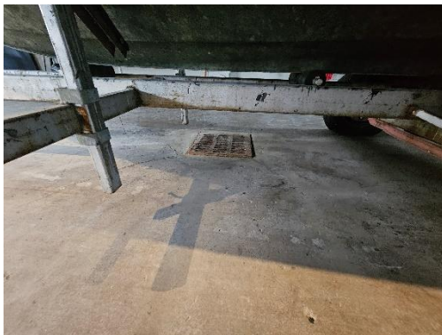
Kuva 86. Hallitilojen ritiläkannellinen kaivo.
