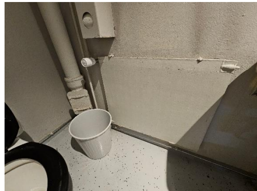
Kuva 71. Osa lämmönluovuttimista on vanhoja paneeliradiaattoreita.
