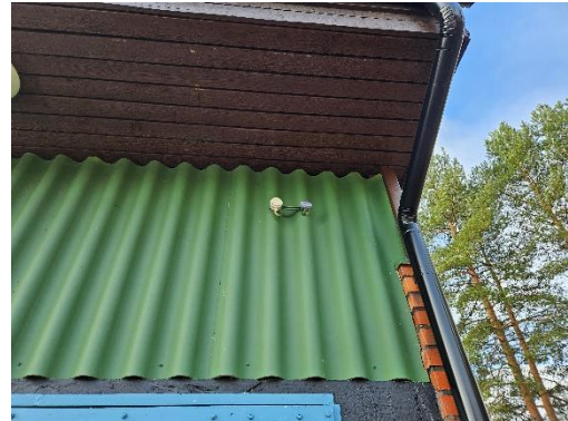
Kuva 114. Ulkoilma-anturit rakennuksen pohjoisjulkisivu.
