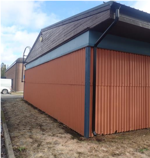
Kuva 27. Julkisivupinnat ovat hyväkuntoiset
