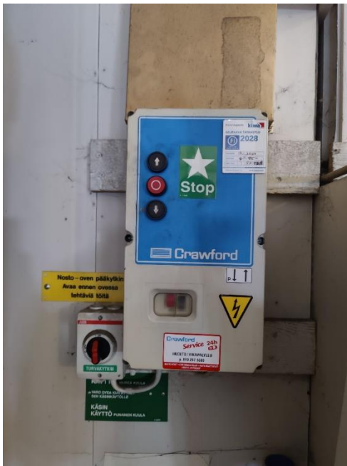
Kuva 126. Nosto-oven keskuslaite.
