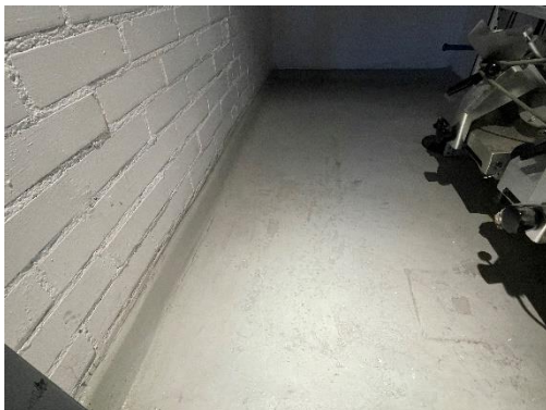
Kuva 51. Hallitilan maalattu betonilattia.
