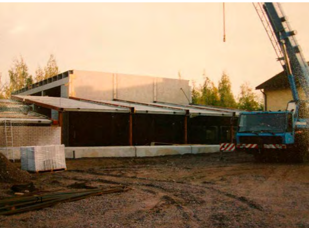
Koulun laajennusosaa rakennetaan 1990-luvun lopulla. Ensimmäisessä kuvassa näkyy myös 1950-luvun osan vanha pääsisäänkäynti. Talman koulun arkisto.
