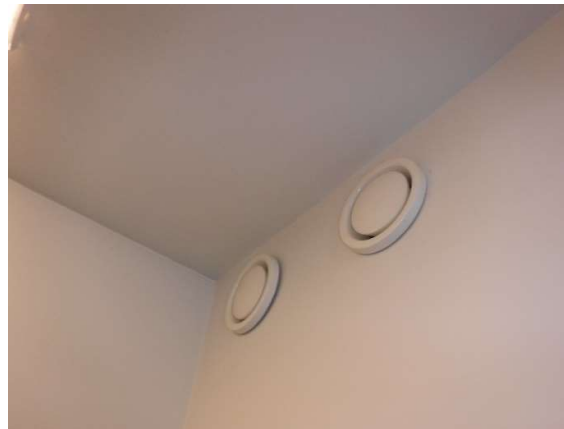
Kuva 59: Poistoilman päätelaitteet ovat kartioventtiileitä.
