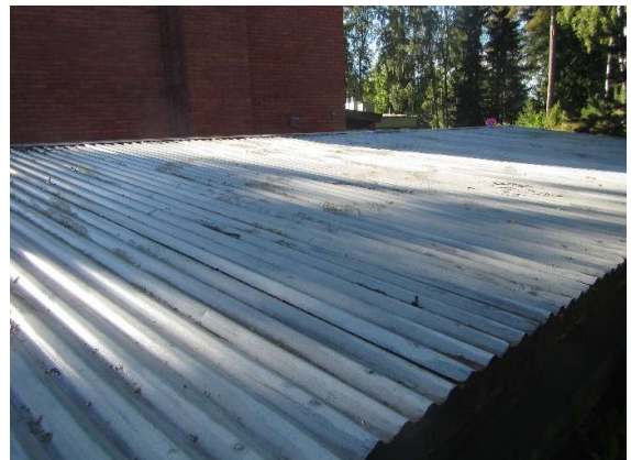
Kuva 30: Ulkovaraston vesikatteenä on aaltomainen profiilipeltikate.
