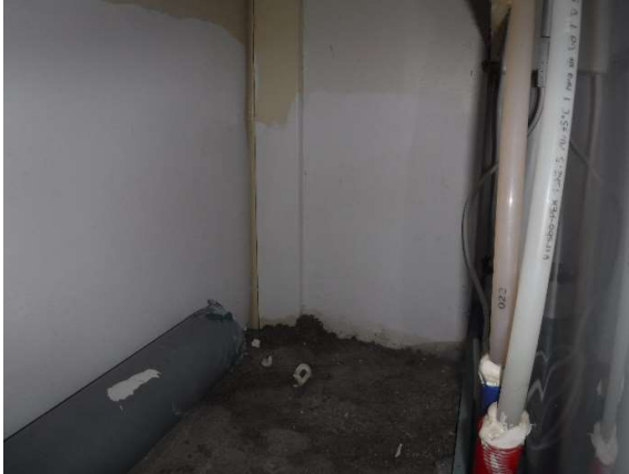
Kuva 47: Muoviputket on asennettu suojaputkiin rakenteiden sisällä.
