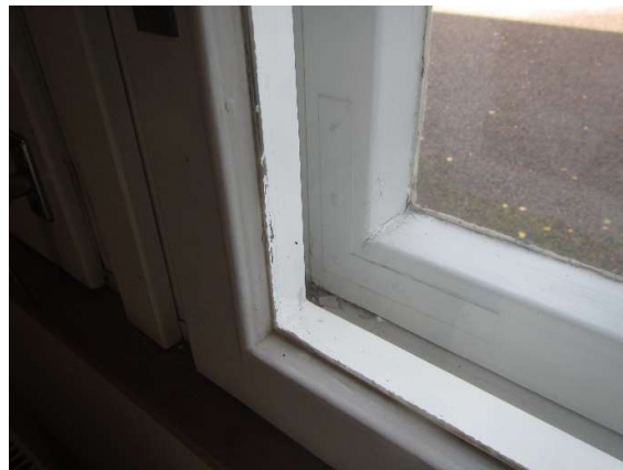
Kuva 21: Puitteiden sisäpintojen maalipinnat ovat melko hyväkuntoisia.
