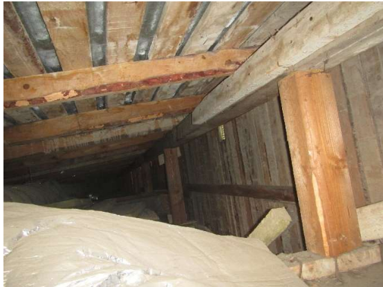
Kuva 27: Yläpohjan tuuletustila tuulettuu hyvin.
