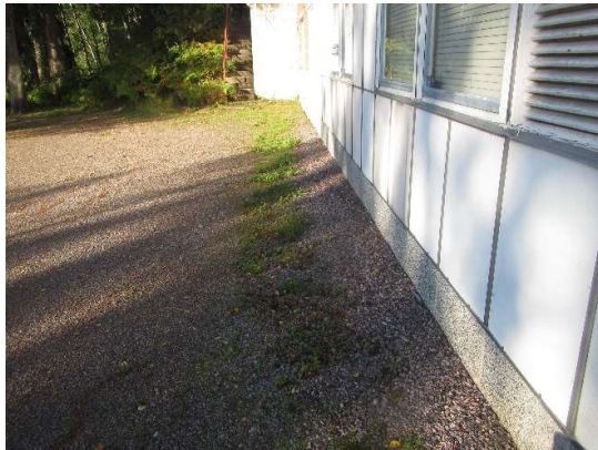
Kuva 2: Alapihan alueella maanpinta on kalteva rakennuksesta pois-päin.
