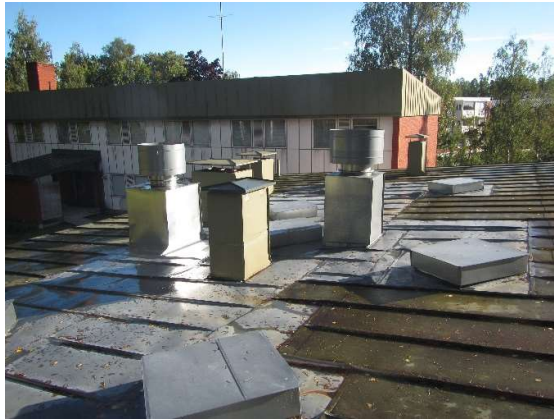
Kuva 25: Katon keskiosan vesikate on uusittu.
