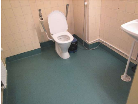
Kuva 38: Yläkerran inva-WC:n lattiapintana on muovimatto.
