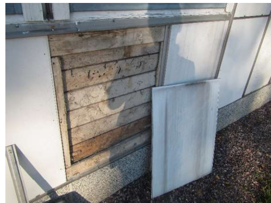
Kuva 11: Yksi levy irrotettiin rakenteen toteamiseksi.
