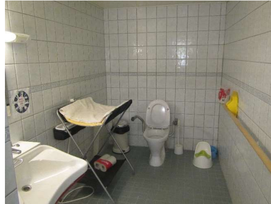
Kuva 39: Alakerran WC-tila on kokonaan laatoitettu.
