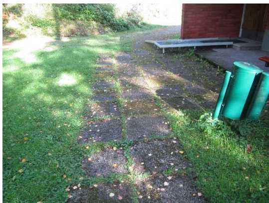
Kuva 4: Rakennuksen länsipäädyn alueella on pieni alue betonilaatoitusta.
