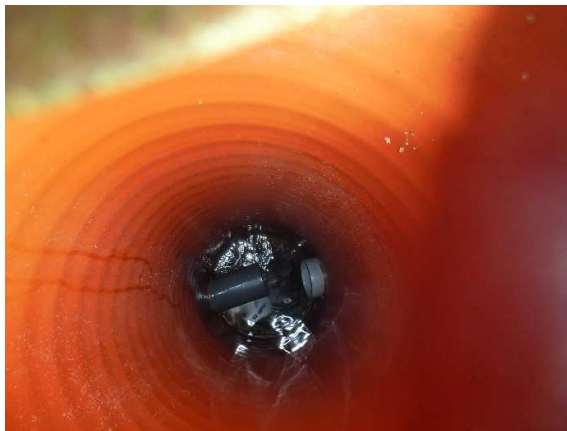
Kuva 54: Sadevesikaivot ja -viemärit ovat muovirakenteisia.
