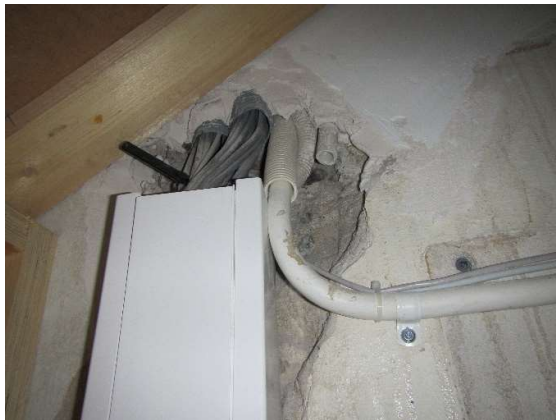
Kuva 71: Näkymää johtokanavasta ja asennusputkesta
