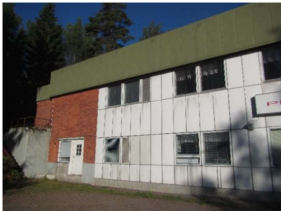
Kuva 10: Pitkien sivujen osalta julkisivuna on kuitusementtilevytykset.
