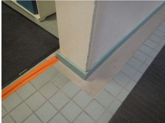
Kuva 32: Alakerran lattiapinnat on laatoitettu keraamisilla laatoilla.
