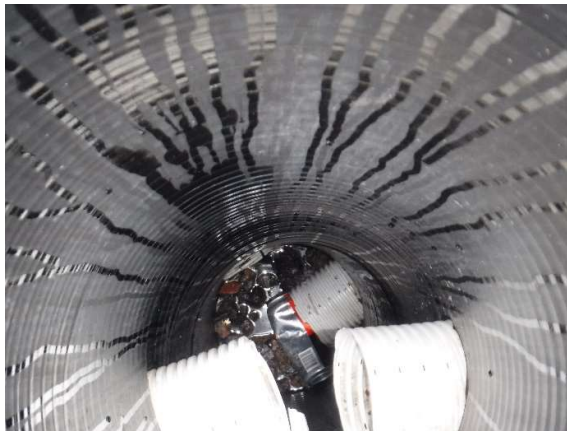
Kuva 6: Salaojien tarkastuskaivoissa on niihin kuulumatonta tavaraa, kuten tölkkejä.
