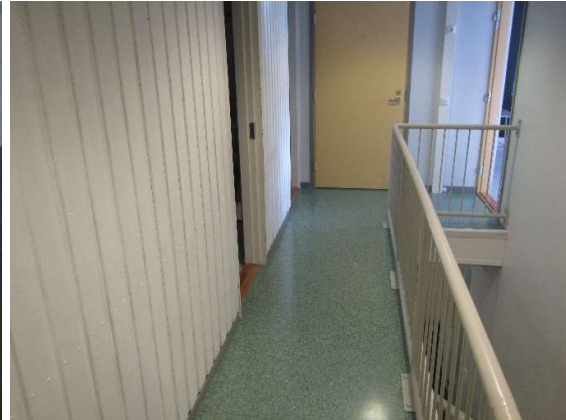
Kuva 33: Yleiskuva yläkerran käytävästä.
