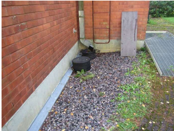
Kuva 24: Talotikkaiden alaosassa on lukittava peitelevy (kuvassa tikkaiden oikealla puolella)
