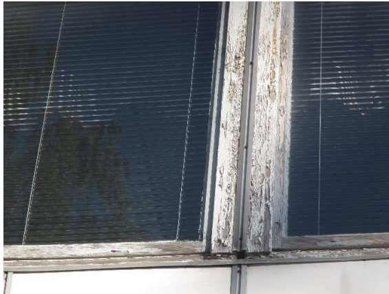
Kuva 18: Ulkopuitteiden ja peitelistöjen maalipinnat ovat monin paikoin irtonaisia.
