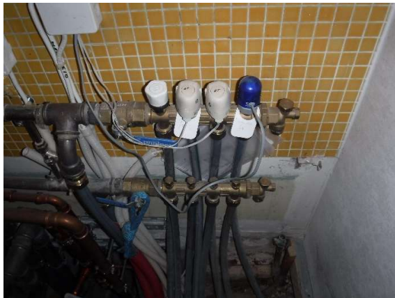
Kuva 43: Lattialämmitysverkoston toimilaitteet on suositeltavaa uusida kunnossapitojakson alussa.
