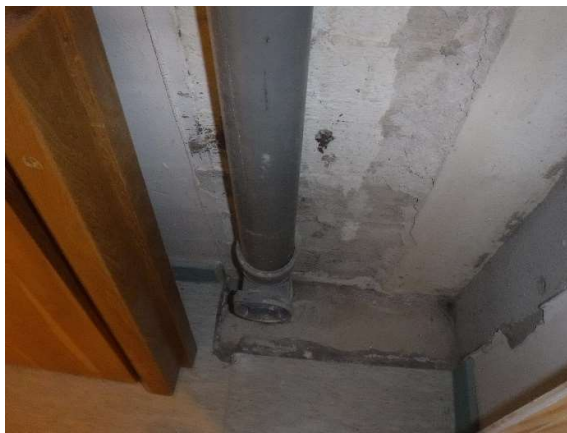
Kuva 50: Uusittua muovista pystyviemäriä.
