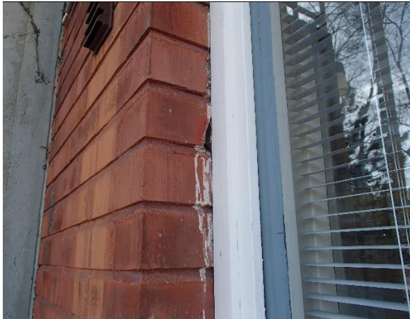
Kuva 18. Rako tiilimuurauksessa ikkuna-ulkoseinäliitoksessa.
