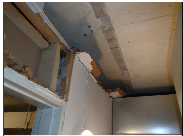
Kuva 5. Reitti välikattotilaan on auki IV-konehuoneessa A102.
