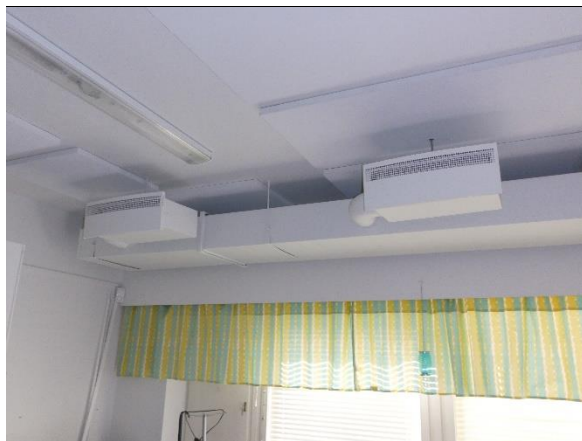
Kuva 30. Tuloilman päätelaitteita
