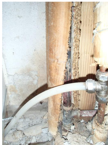
Kuva 11. Teknisessä tilassa kulkee pystysuunnassa putkikuilu.
