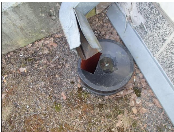
Kuva 22. Syöksytorvet ohjaavat sadevedet sadevesikaivoihin pienistä aukoista.
