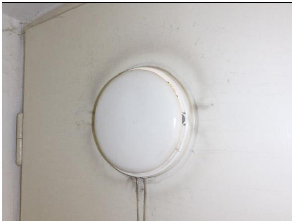
Kuva 34. Painovoimaisen ilmanvaihdon korvausilma-venttiili
