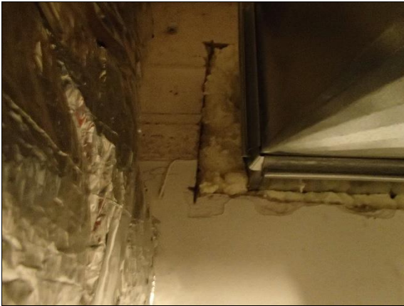
Kuva 6. Näkyvää villaa IV-konehuoneessa.
