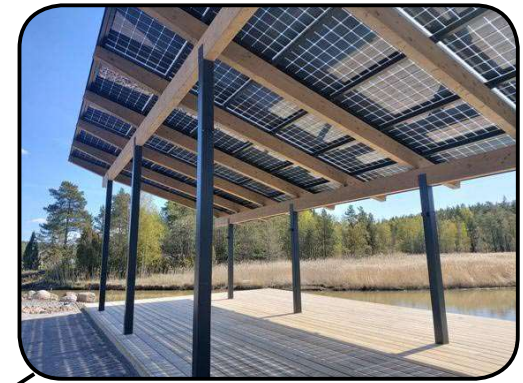
Katos pyörille ja istuinpenkille aurinkokennoilla
