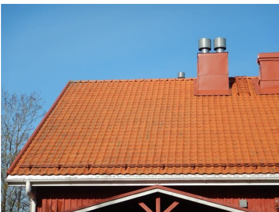
Kuva 28. Vesikate ja kattoturvatuotteet ovat hyväkuntoisia.
