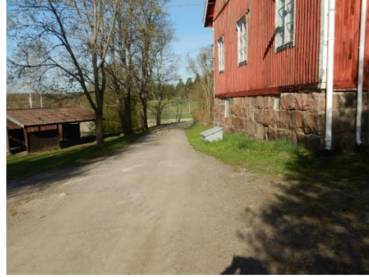
Kuva 2: Piha-alue on sora- ja nurmipintaista. Rakennuksen vierustoilla on hieman puustoa.
