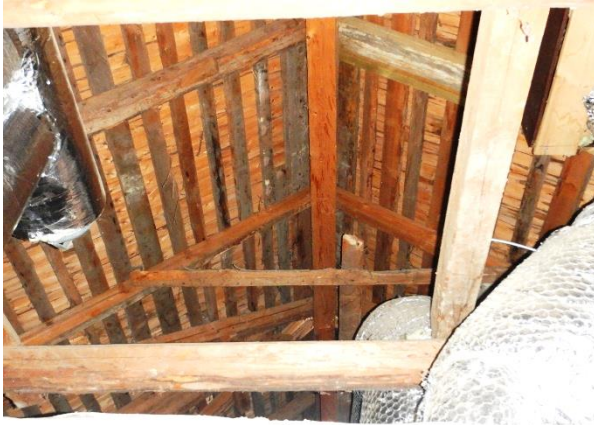
Kuva 9: Rakennuksen vesikaton rungossa ei havaittu muodonmuutoksia eikä viitteitä kosteusvaurioista.
