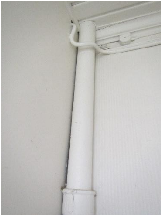
Kuva 42. Entisessä talonmiehen asunnossa on valurautainen tuuletusviemäri.
