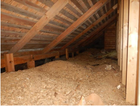
Kuva 24. Yläpohjan rakennetta. Päädyissä tai räystäillä ei havaittu tuuletusreitit.
