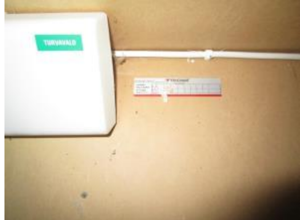
Kuva 73. Turvavalaisin ja tarkastustarra
