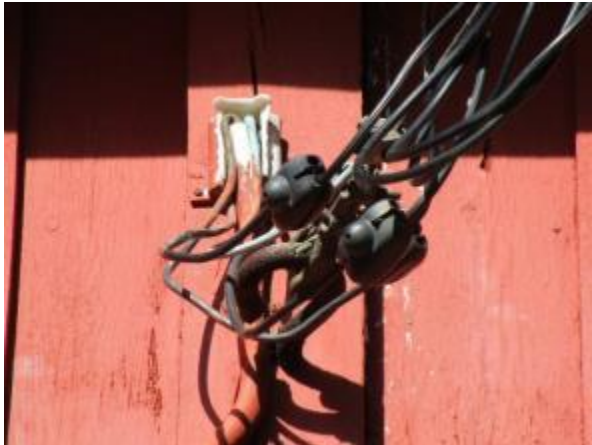
Kuva 54. Rikkoutunut päätehattu
