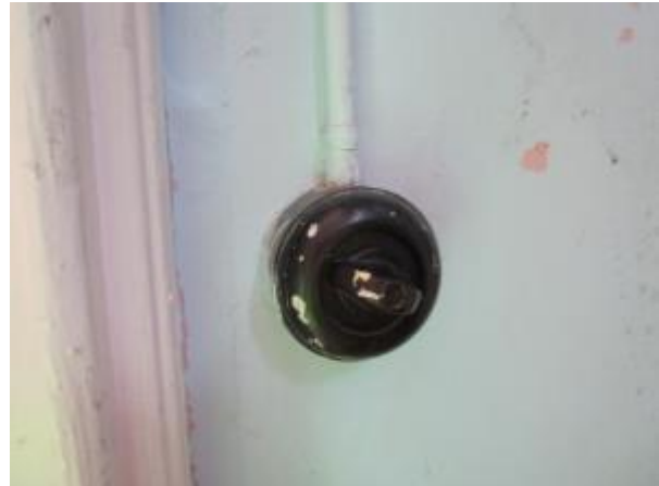
Kuva 61. Pakeliittikuorinen kiertokytkin
