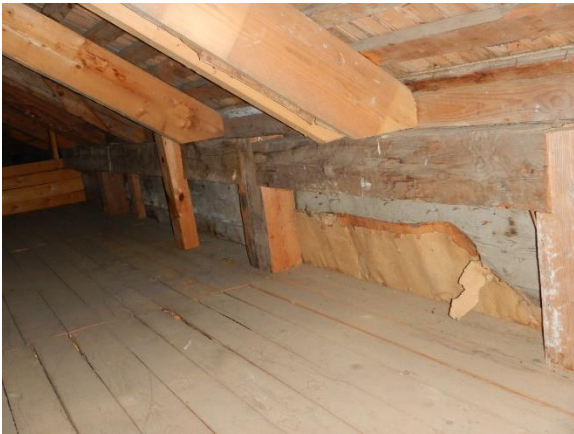
Kuva 26. Lisätuettuja hirsisiä pääkannattajia kypäläorren päällä sekä reunalla pahvimainen tuulensuoja.
