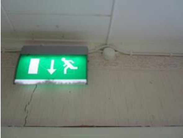
Kuva 72. Poistumistie valaisin
