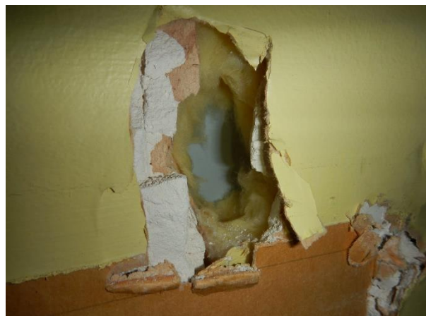
Kuva 12. Rungon sisäpuolella havaittiin puukuitulevy, mineraalivilla ja kipsilevy sisäpintana.
