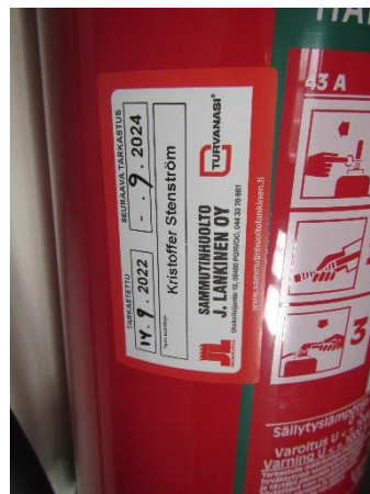
Kuva 49. Sammuttimet on tarkastettu asianmukaisesti.
