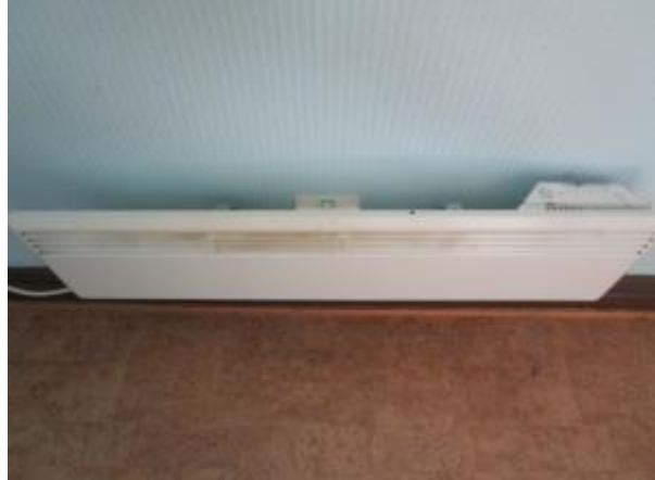
Kuva 69. Uusittu patteri
