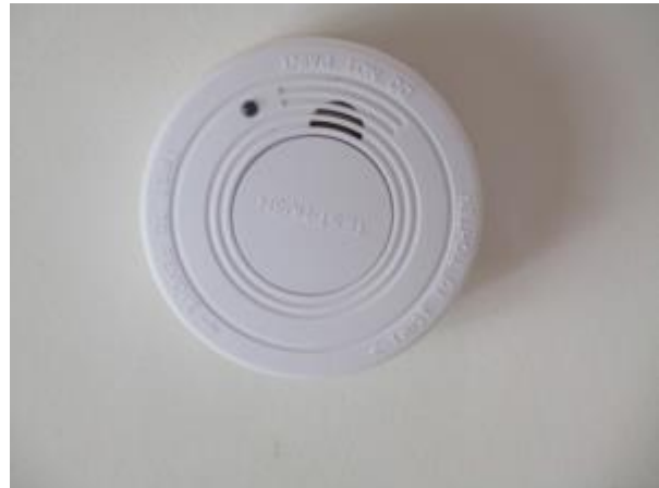
Kuva 80. Palovaroitin katossa
