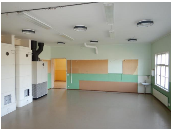
Kuva 30. Tilojen lattiapinnoitteina on muovimattoja 1. kerroksessa.
