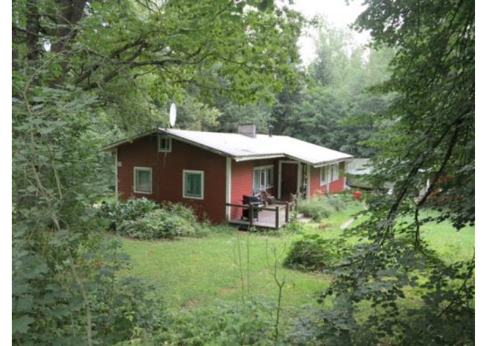
Tyypillinen 1960-luvulla-1970-luvulla valmistunut pitkänomainen, loivalla harjakatolla varustettu rakennus.
