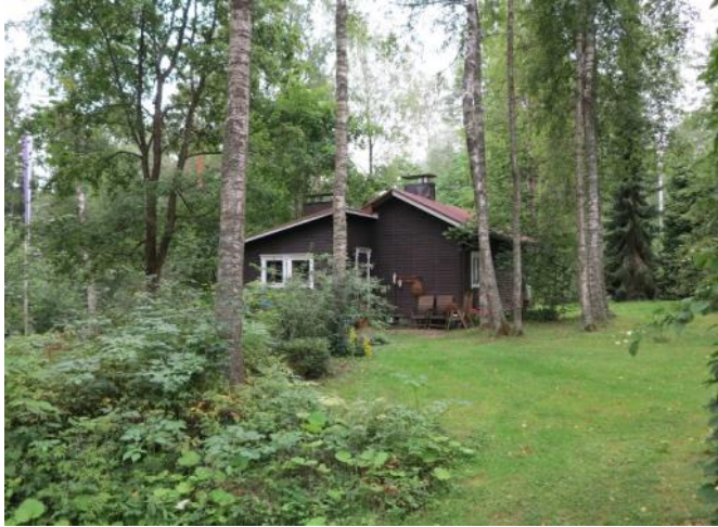
Alueen pohjoisosan kesämökit on rakennettu väljille tonteille metsän keskelle 1940-luvun loppupuolelta alkaen.
