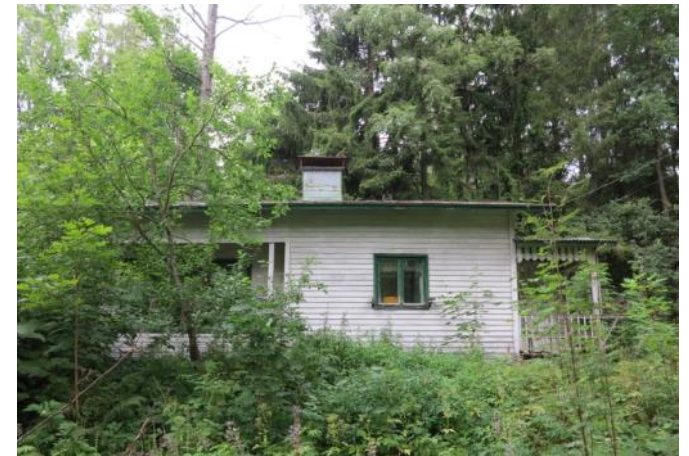
Hyvin säilynyt 1960-luvulla rakennettu kesämökki.
