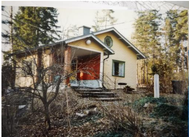
1950-luvun lopulla rakennettu vapaa-ajan asunto on hyvin säilyttänyt ominaispiirteensä.
