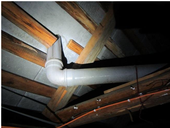
Kuva 73. Kylmässä ullakkotilassa oleva tuuletusviemäri tulee eristää
