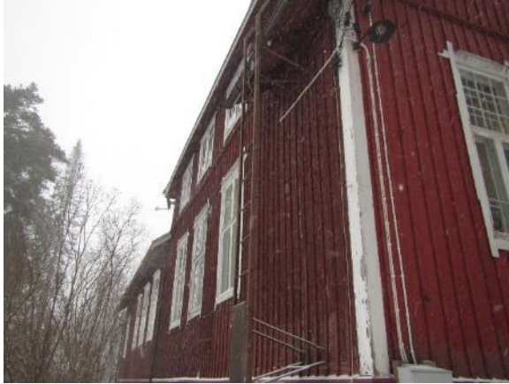
Kuva 49. Katolle johtavat tikkaat.
