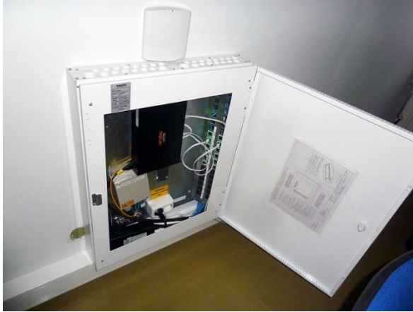
Kuva 94. Paikallisverkon tähtipiste
