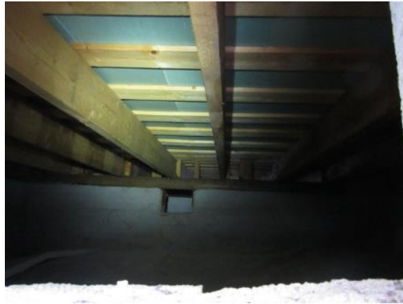
Kuva 16. Laajennusosan alapohjarakenteet olivat hyväkuntoisia.
