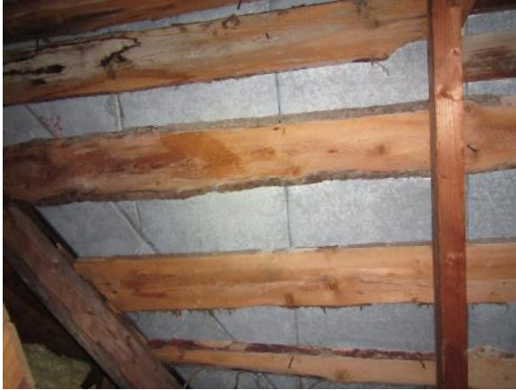
Kuva 45. Vesikatteena on harvalaudoituksen päälle tehty konesaumattu peltikate.
