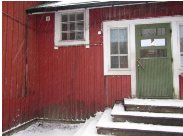
Kuva 38. Pääsisäänkäynnin puinen ovi.
