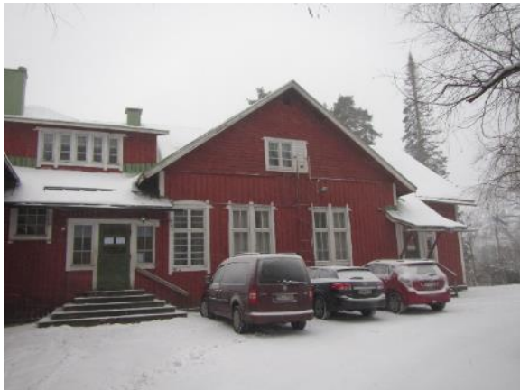
Kuva 2. Yläpihan puolella, pitkän seinän osalla, maanpinnat ovat tasaisia.
