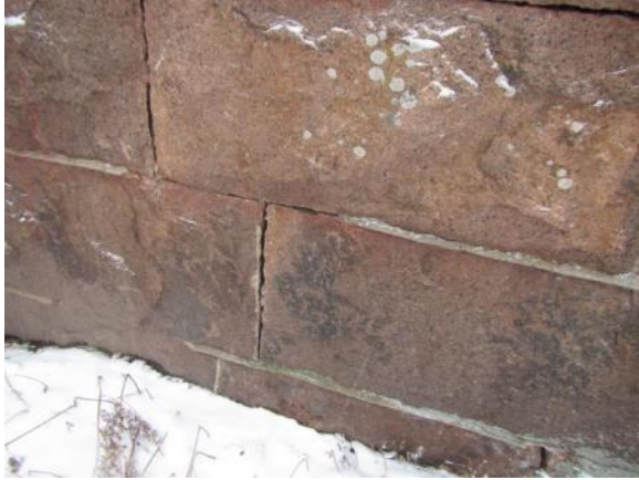
Kuva 11. Makkarasaumat ovat varisseet pois.
