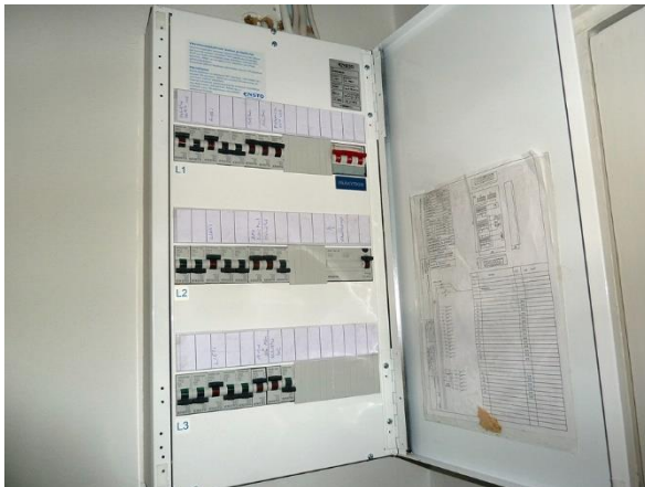
Kuva 89. Nykyaikaiseen tapaan varusteltu ryhmäkeskus
