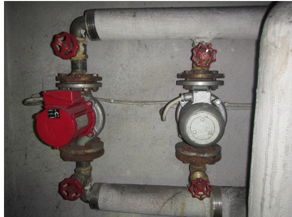
Kuva 64 Lämmitysverkoston kiertopumput
