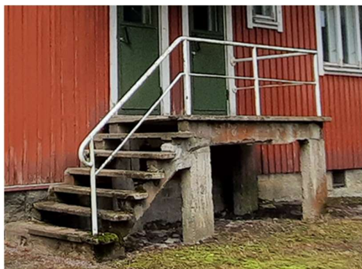
Vaurioituneet betoniportaajat
