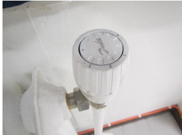
Kuva 66. Uudempi termostaattinen patteriventtiili
