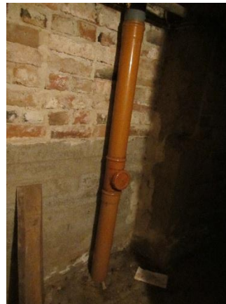
Kuva 74. Jätevesiviemäri kellaritilassa
