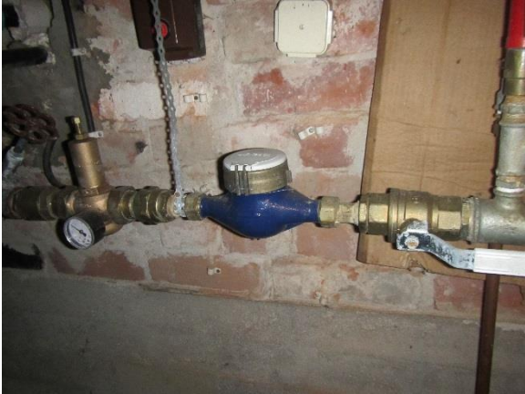
Kuva 69. Päävesimittari
