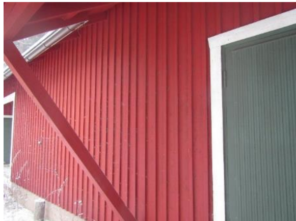
Kuva 10. Piharakennuksen maalipinnat ovat hyväkuntoisia.
