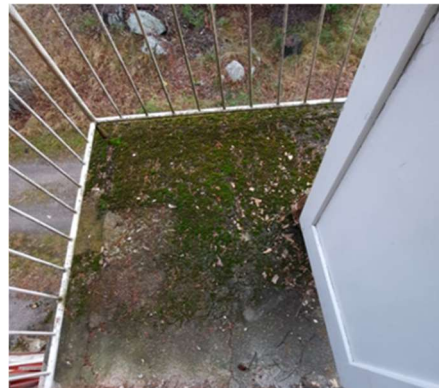
Vaurioitunut betoniparveke
