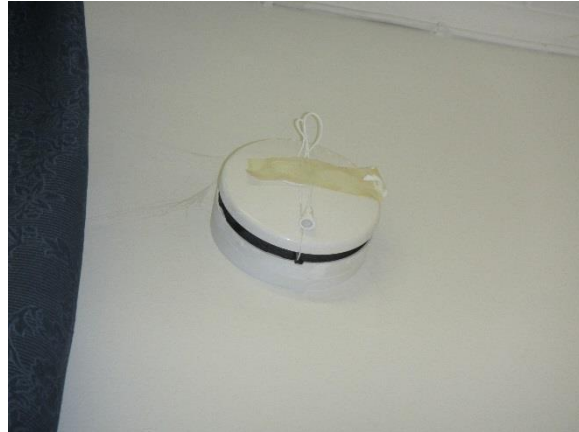
Kuva 82. Korvausilmaventtiili
