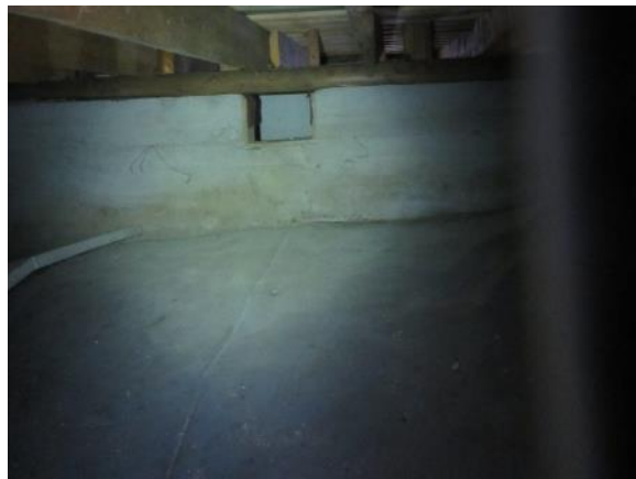
Kuva 24. Laajennusosalla maanpinnat ovat peitetty suodatinkankaalla. Ryömintätila on siisti.
