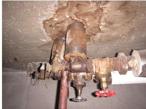
Kuva 68 Lämmitysverkoston nousujohdot
