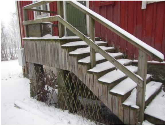
Kuva 43. Puurakenteinen porras
