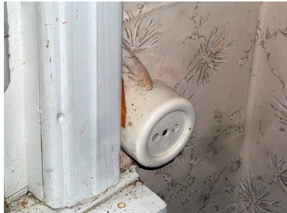
Kuva 91. O-luokan pistorasia. Sallittu edelleen vaarattomissa olosuhteissa (mm. >4 m maadoitetuista rasioista).
