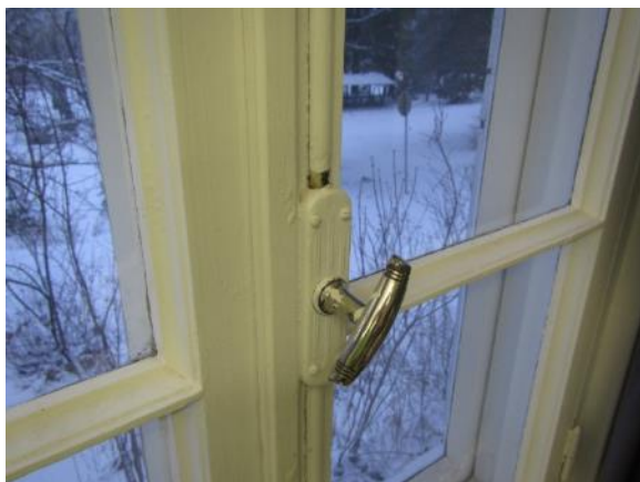
Kuva 34. Espanjolettien pitkittäistangot ovat maalattu yli, joka heikentää käyntiä.
