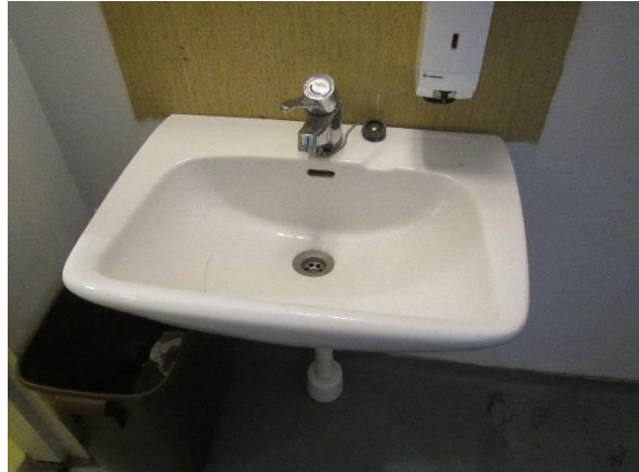
Kuva 72 Allashanoja on uusittu tarpeen mukaan
