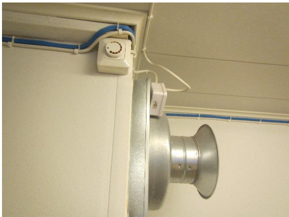
Kuva 79. Tilaan asennettu poistoilmapuhallin ja poistoilmasäleikkö
