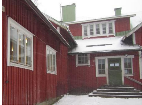
Kuva 50. Pääsisäänkäynnin yläpuolella on lumiesteet.
