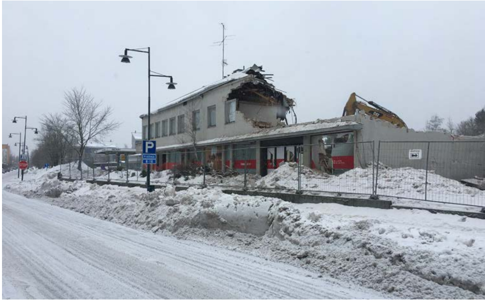
1940-luvulla rakennetun Centrumin purkutyömaa helmikuussa 2019. Nikkilän muutospaineet ovat johtamassa tilanteseen, jossa toisen maailmansodan jälkeinen rakennusperintö on uhattuna.
