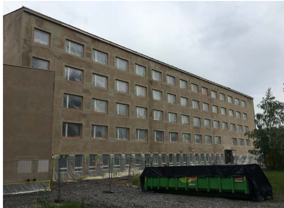
Sairaalan 1950-luvun lisärakennus peruskorjauksessa kesällä 2019.
