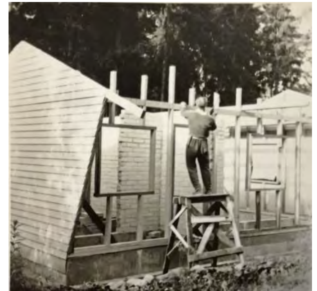
Rakennusmestari Arhovaaran kiinteistön 4-587 mökki rakenteilla 1950-luvun lopulla. Kuva yksit.
