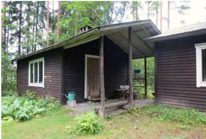
Vaakalimilaudoituus ja ruskea kuultokäsittely on tyyppinen julkisivukäsittely.
