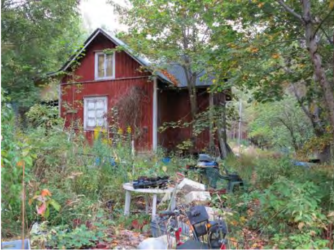
Vanhinta rakennuskantaa edustaa Grötkärin pientilan umpeen kasvaneen pihan ympäröimä asuinrakennus.
