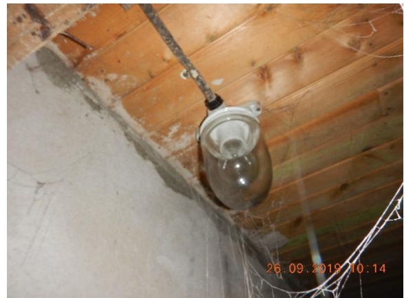
Kuva 111. Vanha hehkulamppuvalaisin.
