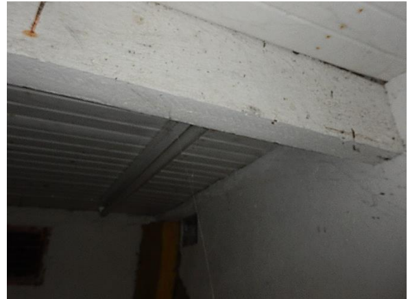
Kuva 31. Kellarin osalta välipohjat ovat betonirakenteisia.
