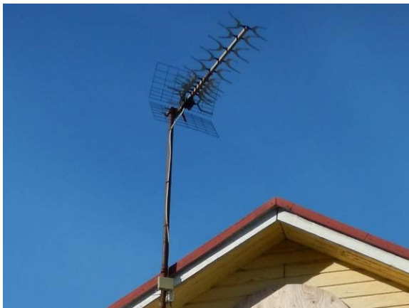
Kuva 99. Harava-antenni katolla.
