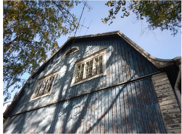
Kuva 40. Etelän puoleinen julkisivu.
