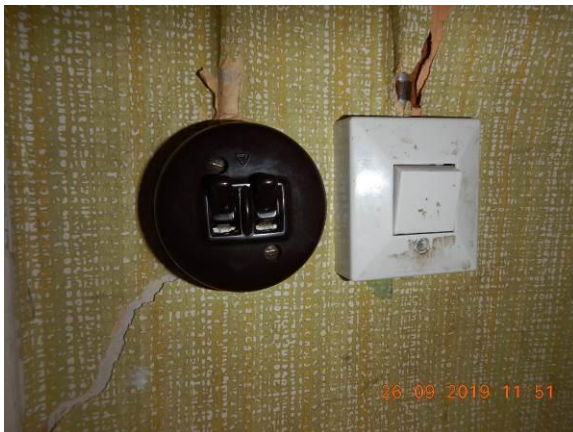
Kuva 97. Eri-ikäisiä katkaisijoita. Johdotukset vanhoja.
