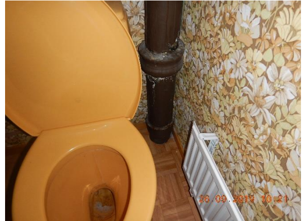
Kuva 96. Alkuperäinen valurautainen tuuletusviemäri yläkerran WC-tilassa
