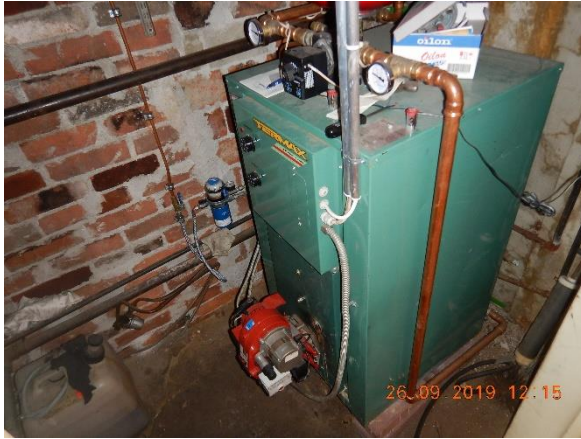
Kuva 69. Öljylämmityskattila.
