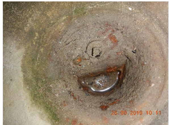
Kuva 98. Kellarin alkuperäinen valurautakaivo
