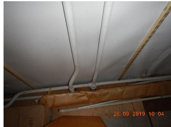
Kuva 92. Pinta-asenteisia lämpöjohtoja
