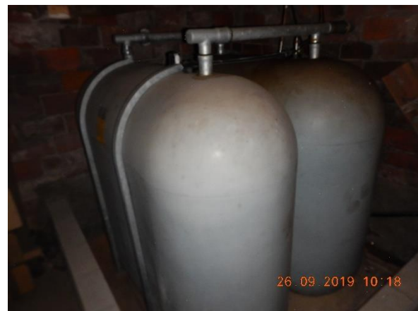
Kuva 90. Öljysäiliöt
