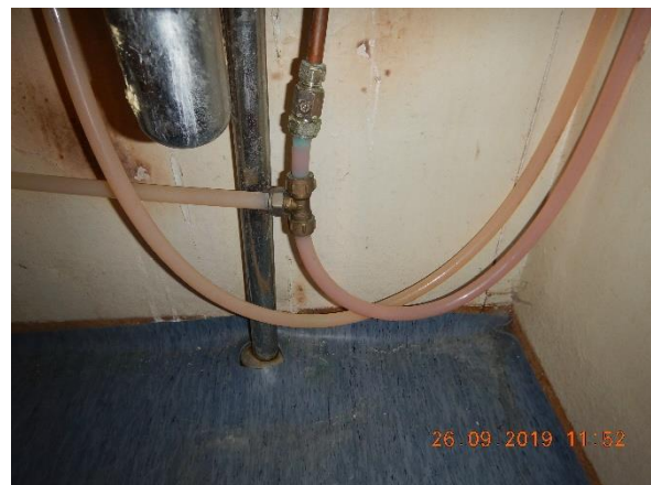
Kuva 86. Muovisia käyttövesijohtoja
