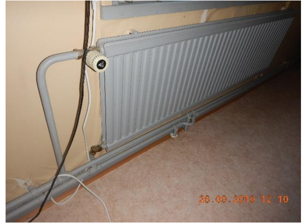
Kuva 78. Termostaattinen patteriventtiili
