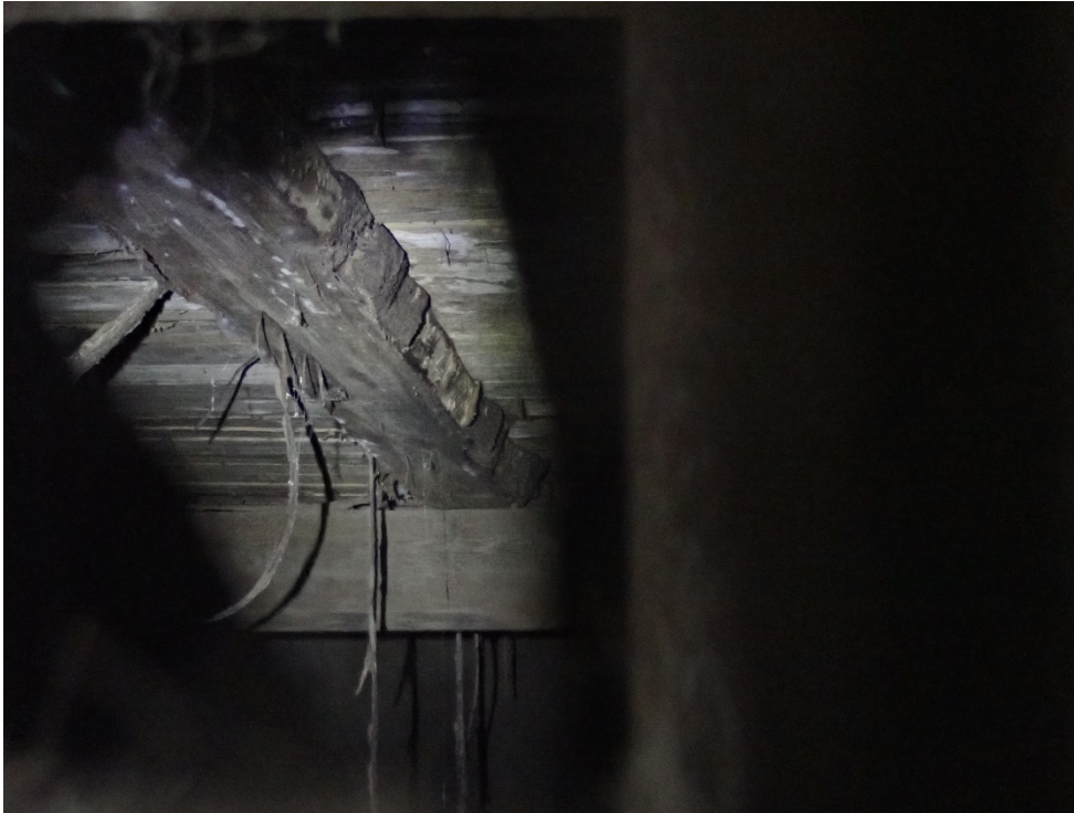
Ryömintätilaisen alapohjan lahoa ja homeista täytepohjaa.
