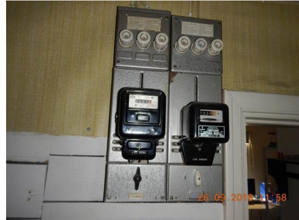
Kuva 94. Alamittauskeskukset.
