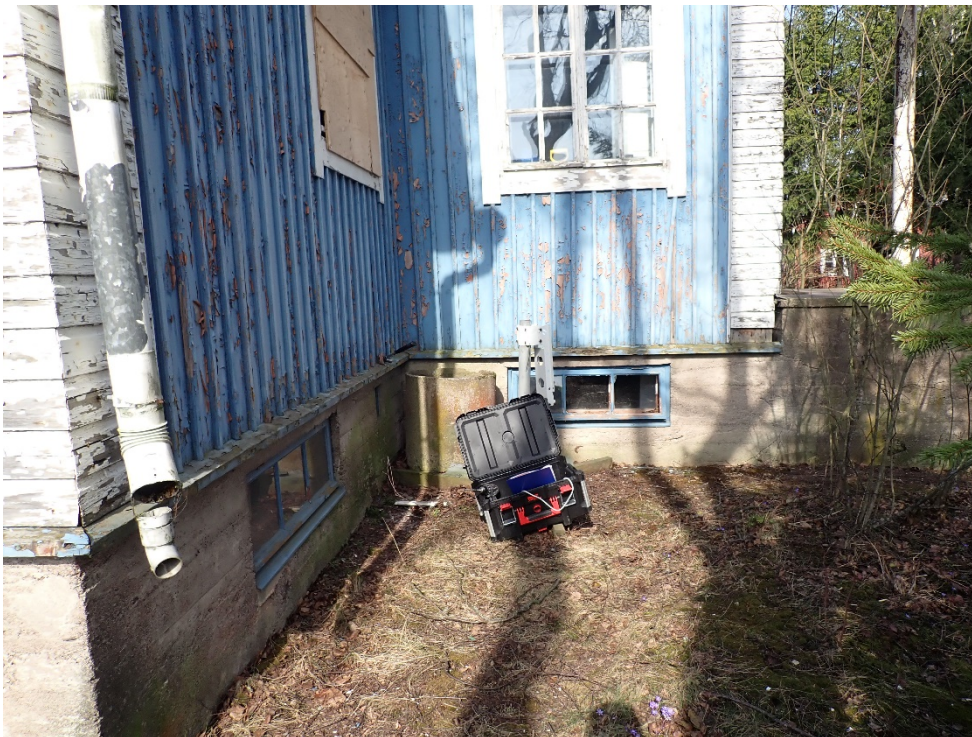
Rakennuksen itäisivulla on hyvä sokkelikorkeus.
