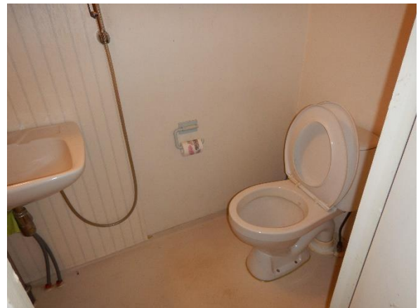
Kuva 61. Toisen kerroksen aulatilan wc.
