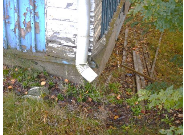
Kuva 10. Syöksytorvista tulevat vedet ohjataan rakennuksen vierustoille.
