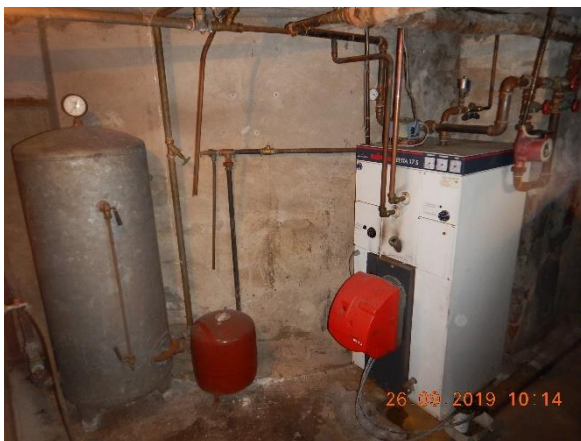
Kuva 89. Öljylämmityslaitteisto
