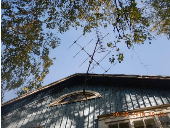
Kuva 112. Harava-antennit katolla.
