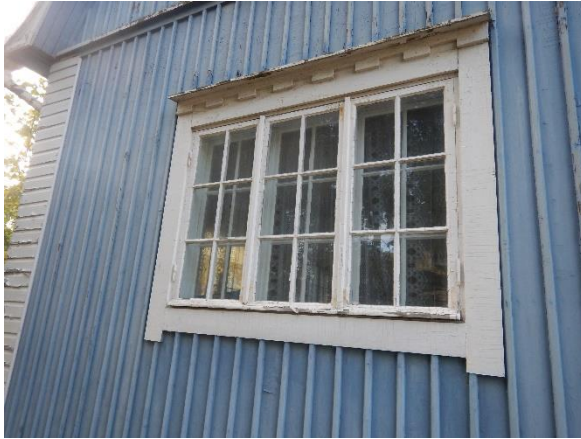
Kuva 54. Alkuperäinen puuikkuna rakennuksen pohjoispäädyssä.
