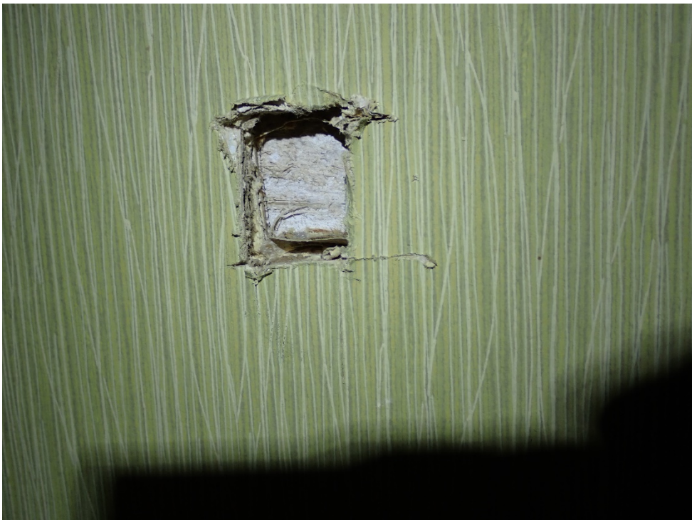
Yläkerran ulkoseinissä purueristysten sisäpuolella on käytetty laudoitukseen betonimuottilautoja.
