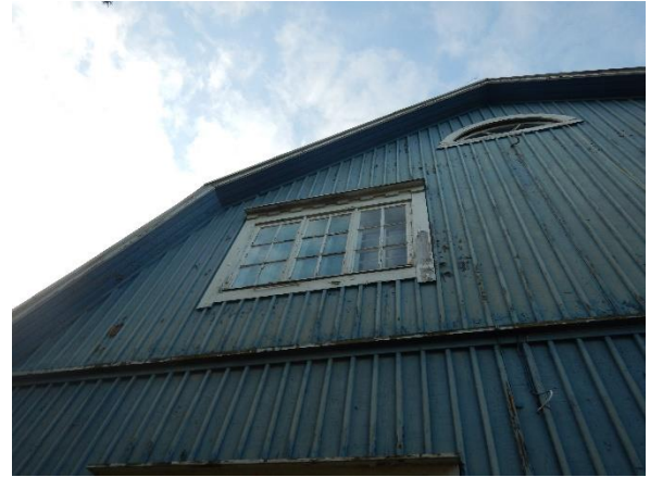
Kuva 55. Ullakon ikkuna on alkuperäinen ns. lunetti-ikkuna.
