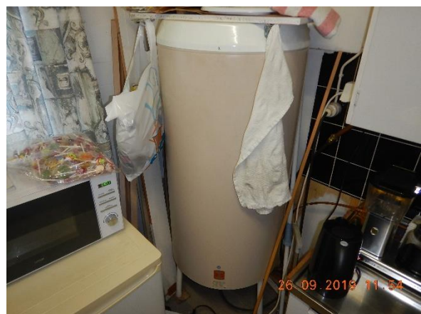
Kuva 74. Sähkötoiminen lämminvesivaraaja
