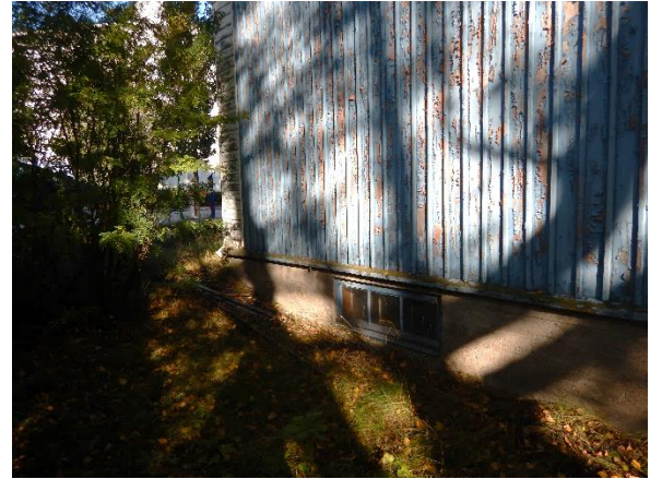
Kuva 17. Yleiskuva rakennuksen eteläpäädyn sokkelista.
