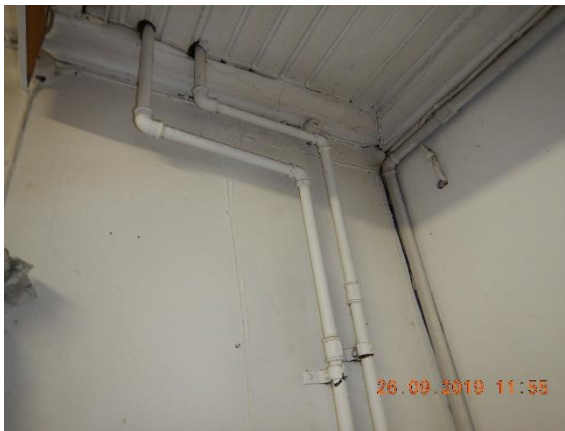
Kuva 75. Pinta-asenteisia lämpöjohtoja
