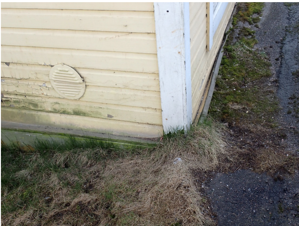
Rakennuksen luoteisnurkka. Kuvassa ei näy sokkelibetonia, sillä se on alempana. Nurkan molemmilla puolilla on peltiä lautojen ja maan välissä.
