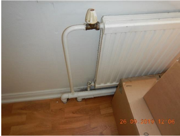
Kuva 77. Käsisäätöinen patteriventtiili
