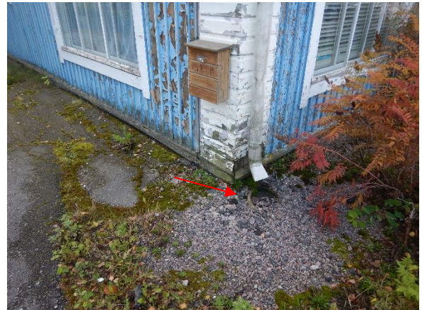
Kuva 12. Sadevesikaivo on osittain päällysteiden alla.
