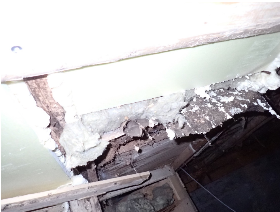
Korjattua wc:n lattiaa. Korjattu liimaamalla uretaanilevyjä läpilahoihin lattiavasoihin.
