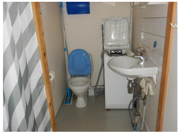
Kuva 59. 2. kerroksen toisessa wc:n yhteydessä on myös suihku.
