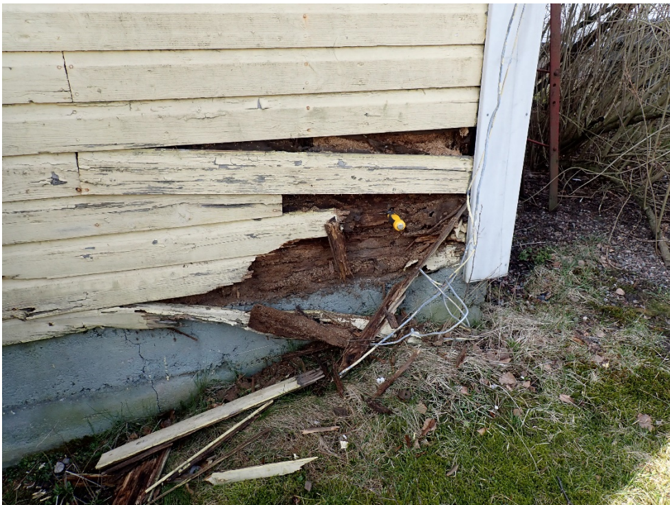
Pihan puoleista seinää. Tässä laudat olivat jotenkuten paikoillaan, mutta kenkä meni laudoista läpi ja upposi alahirsien puoliväliin.
