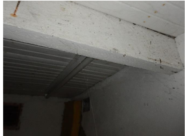
Kuva 31. Kellarin osalta välipohjat ovat betonirakenteisia.
