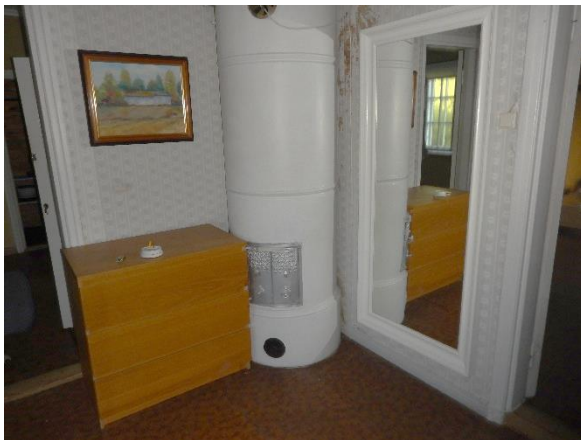
Kuva 87. Toisen kerroksen pönttöuuni, joka ei ole käytössä.
