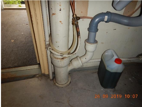
Kuva 95. Uusittu viemäriliitos alkuperäiseen valurautaviemäriin
