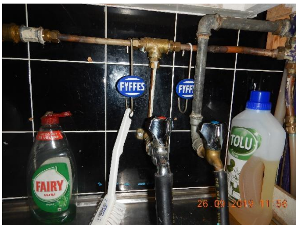
Kuva 85. Keittiön vesipistekytkenät
