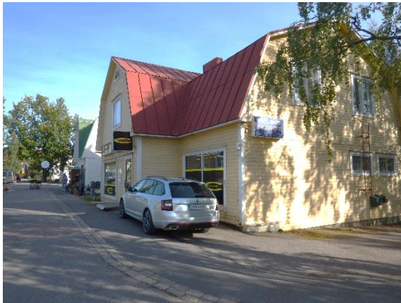
Kuva 2. Päälysteitä Iso Kylätien puolella
