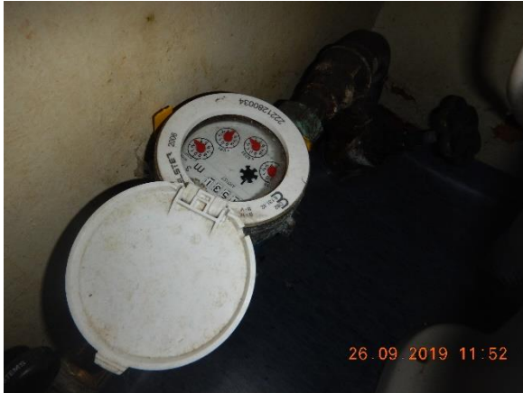
Kuva 83. Vesimittari
