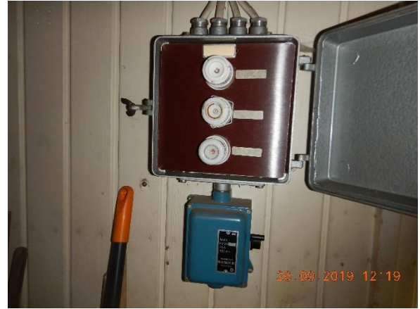
Kuva 70. Sähköpääkeskus.
