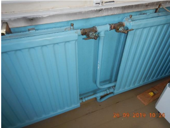
Kuva 93. Alkuperäisiä teräslevypattereita ja venttiilejä
