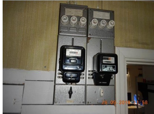
Kuva 94. Alamittauskeskukset.
