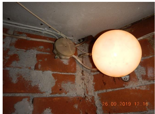
Kuva 98. Vanha hehkulamppuvalaisin.
