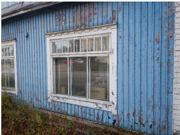
Kuva 52. Myymälän ikkunat ovat alkuperäisiä puuikkunoita.
