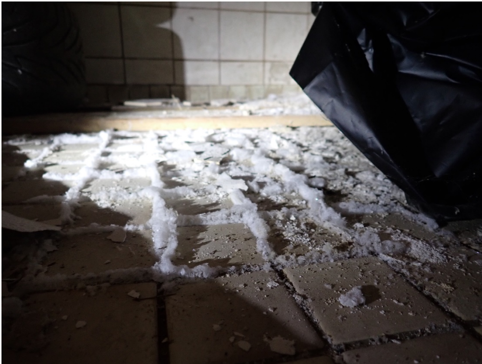
Kalkkihärmää kaakelisaumoissa. Betonialapohjan läpi kulkeutuva vesi kuljettaa suoloja. Kun vesi on haihtunut saumojen kohdalla, niin suolat ovat jääneet. Nämä kalkkihärmät ovat n. 10-20 mm korkeita.
