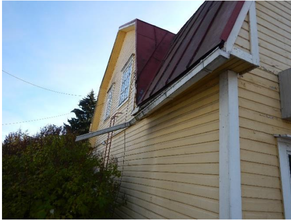
Kuva 7. Ainoastaan rakennuksen pohjoispäädyssä on kattokourut ja lyhyt ulosheittäjä.
