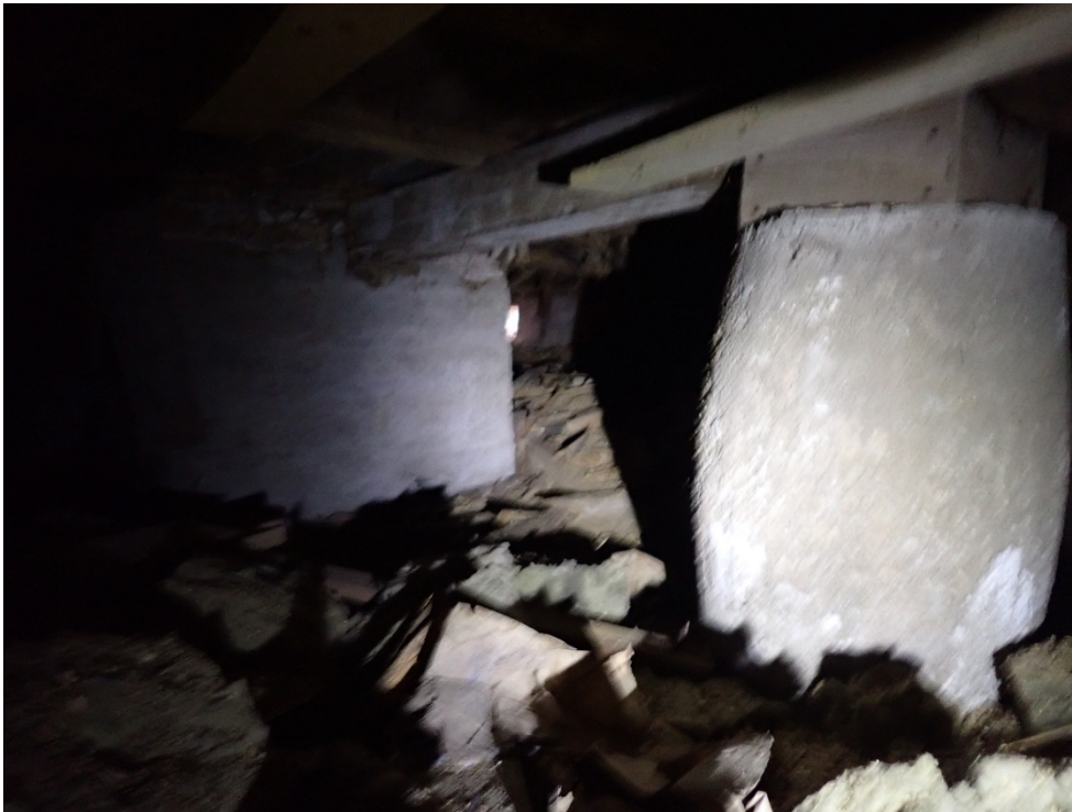
Rakennuksen alla olevia välitukia on valettu betonista puutynnyreiden sisään.
