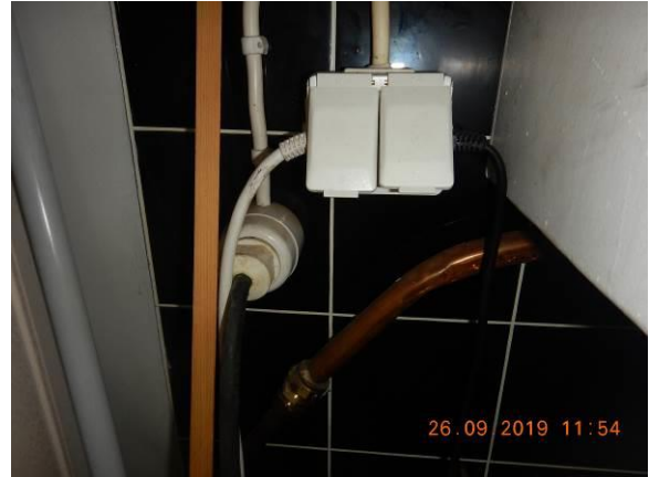
Kuva 96. Jälkiasennettu pistorasia.
