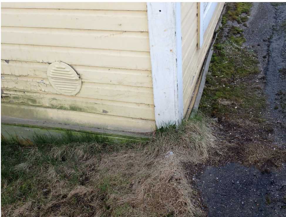
Rakennuksen luoteisnurkka. Kuvassa ei näy sokkelibetonia, sillä se on alempana. Nurkan molemmilla puolilla on peltiä lautojen ja maan välissä.
