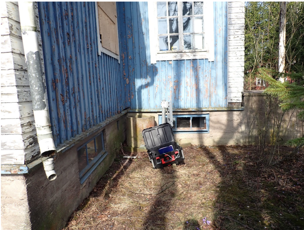
Rakennuksen itäisivulla on hyvä sokkelikorkeus.
