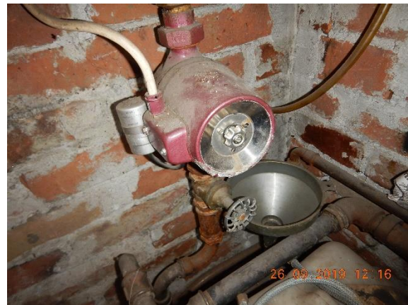
Kuva 76. Lämmitysverkoston kiertopumppu
