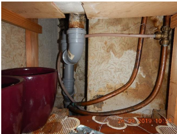
Kuva 97. Keittiön allaskaapin vesi- ja viemärikytkennät
