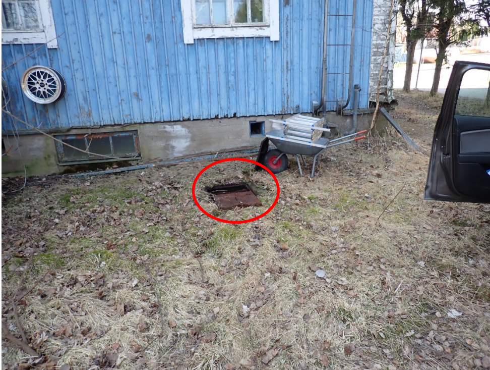
Pihalla olevan kaivon sijainti.
