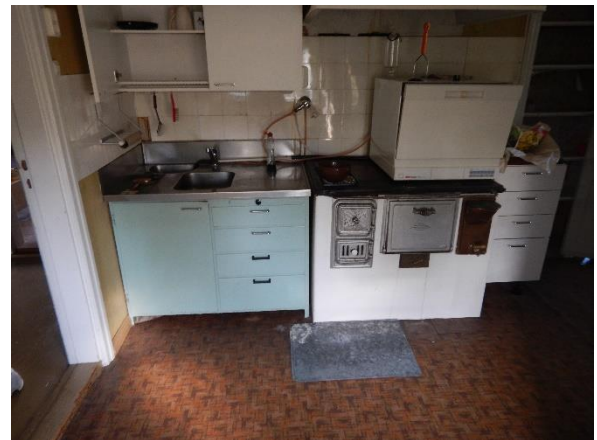
Kuva 88. Toisen kerroksen puuhella.
