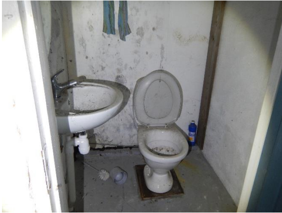
Kuva 71. Yleiskuva kellarikerroksen wc.
