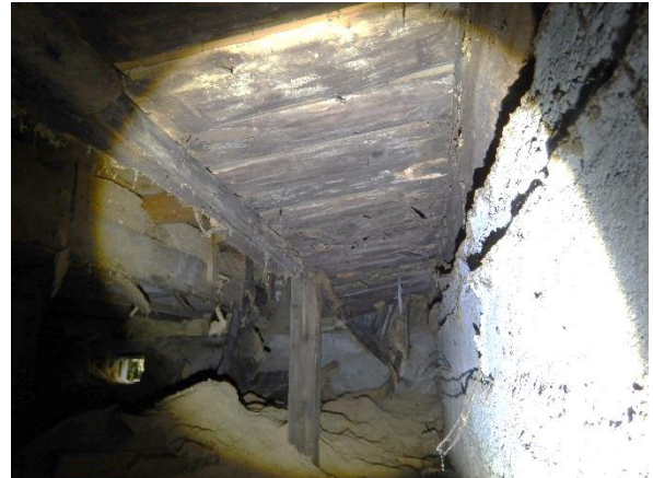
Kuva 18. Lahovaurioituneita alapohjarakenteita.
