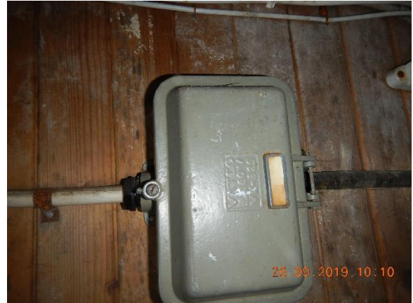
Kuva 108. Päävarokekotelo.
