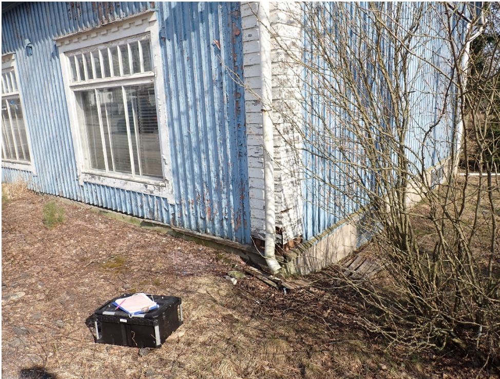
Kuvassa nurkasta vasempaan on Iso Kylätien puoleinen lännen puoleinen sivu, jossa sokkeli häviää maan alle rakennuksen keskivaiheilla.
