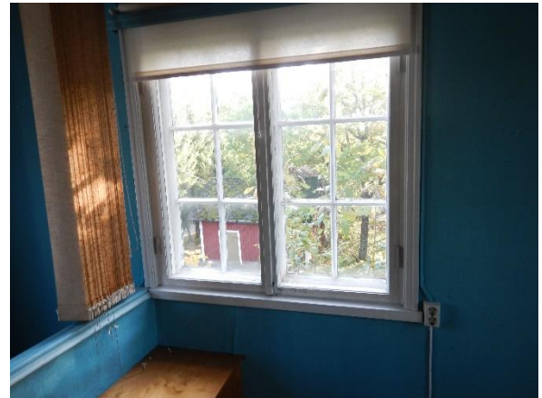
Kuva 57. Ikkunoiden sisäpuutteet ovat yksilasisia.
