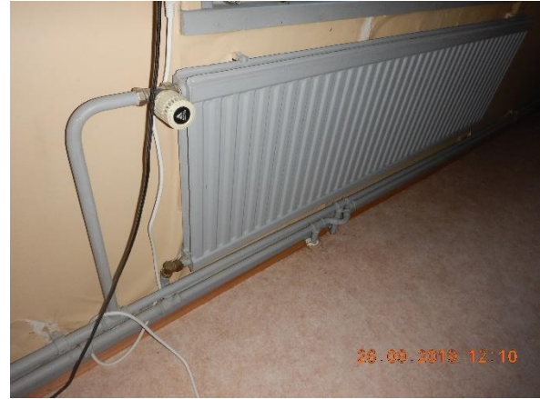
Kuva 78. Termostaattinen patteriventtiili
