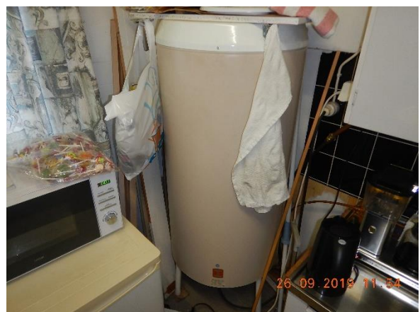
Kuva 74. Sähkötoiminen lämminvesivaraaja
