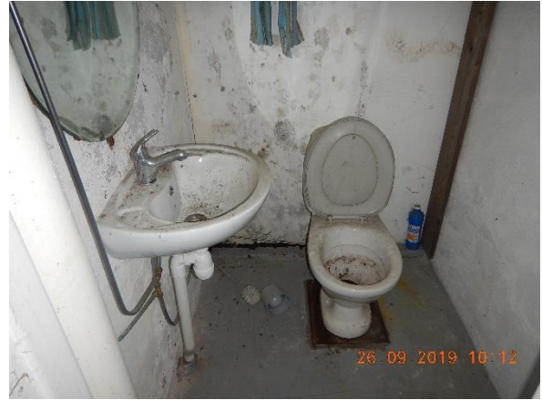
Kuva 104. Alakerran WC-tilan vesi- ja viemärikalusteita.
