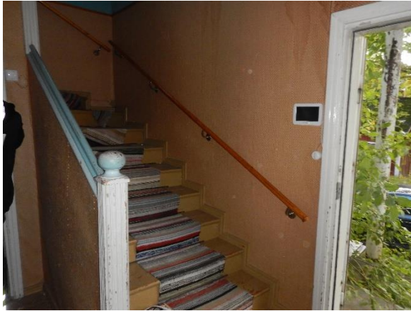
Kuva 69. Yleiskuva toisen kerroksen portaista.
