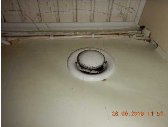
Kuva 91. Poistoilmaventtiili
