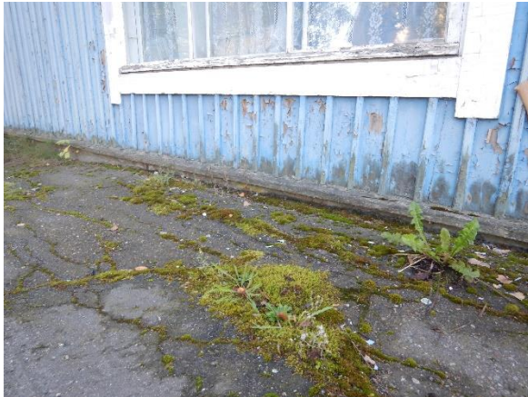
Kuva 51. Seinän puurakenteinen alaosa on maanpinnan tasalla rakennuksen pohjoispäädyssä.
