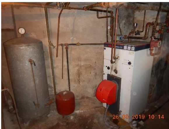
Kuva 89. Öljylämmityslaitteisto
