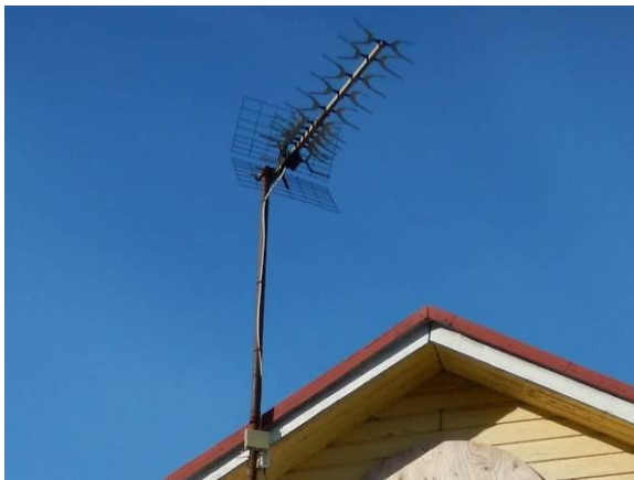
Kuva 99. Harava-antenni katolla.
