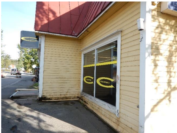
Kuva 40. Yleiskuva liiketilan ikkunoista.
