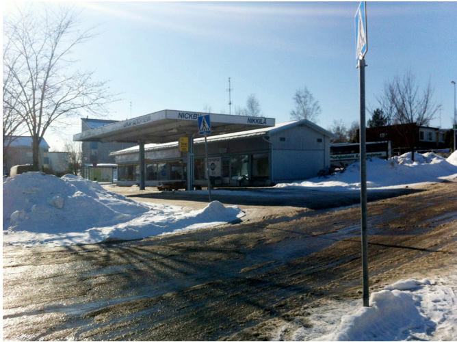
Suunniteltavalla tontilla sijaitsee nykyisin yksikerroksinen rakennus, jossa on linja-autoasema sekä liiketilaa.
