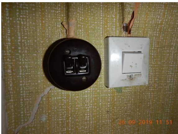
Kuva 97. Eri-ikäisiä katkaisijoita. Johdotukset vanhoja.
