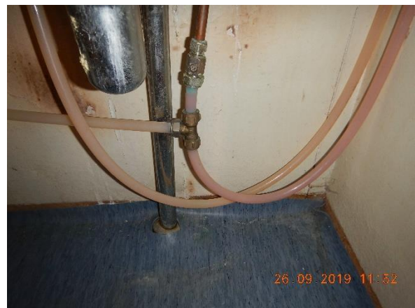
Kuva 86. Muovisia käyttövesijohtoja
