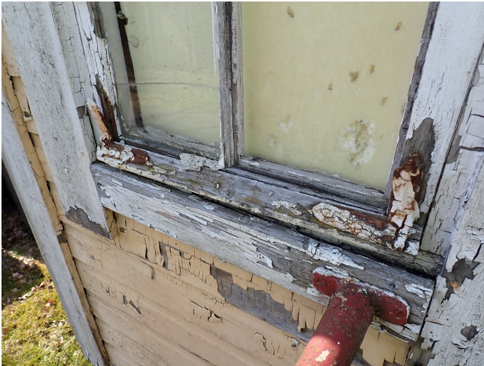
Kylmän kuistin ikkuna ja seinää.
