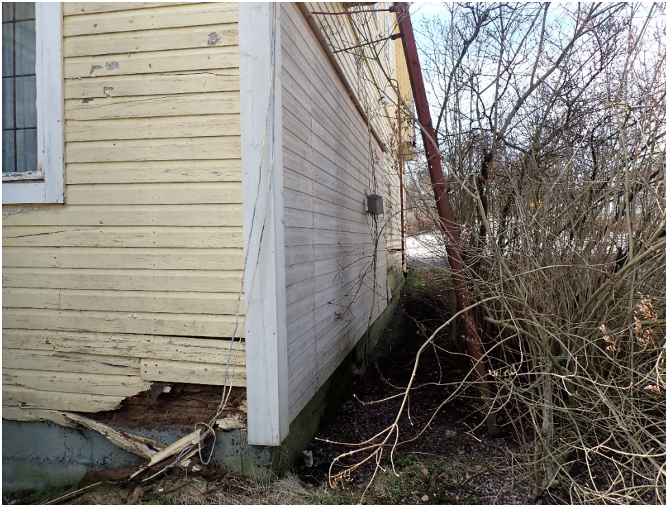
Pohjoisseinän korjattua osuutta. Vieressä lapioitavassa kunnossa olevaa seinärunkoa.
