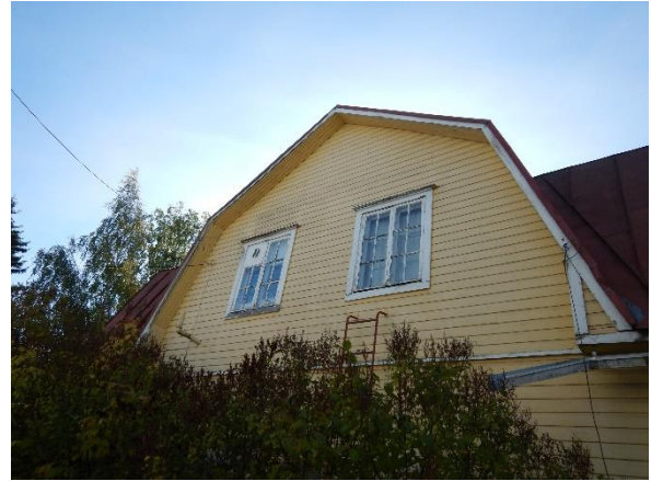
Kuva 27. Pohjoisen puoleinen julkisivu.
