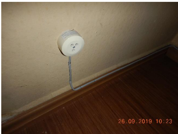
Kuva 113. Puhelinpistorasia.
