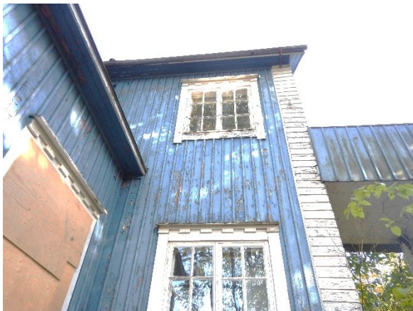
Kuva 43. Julkisivumaali lehteilee.
